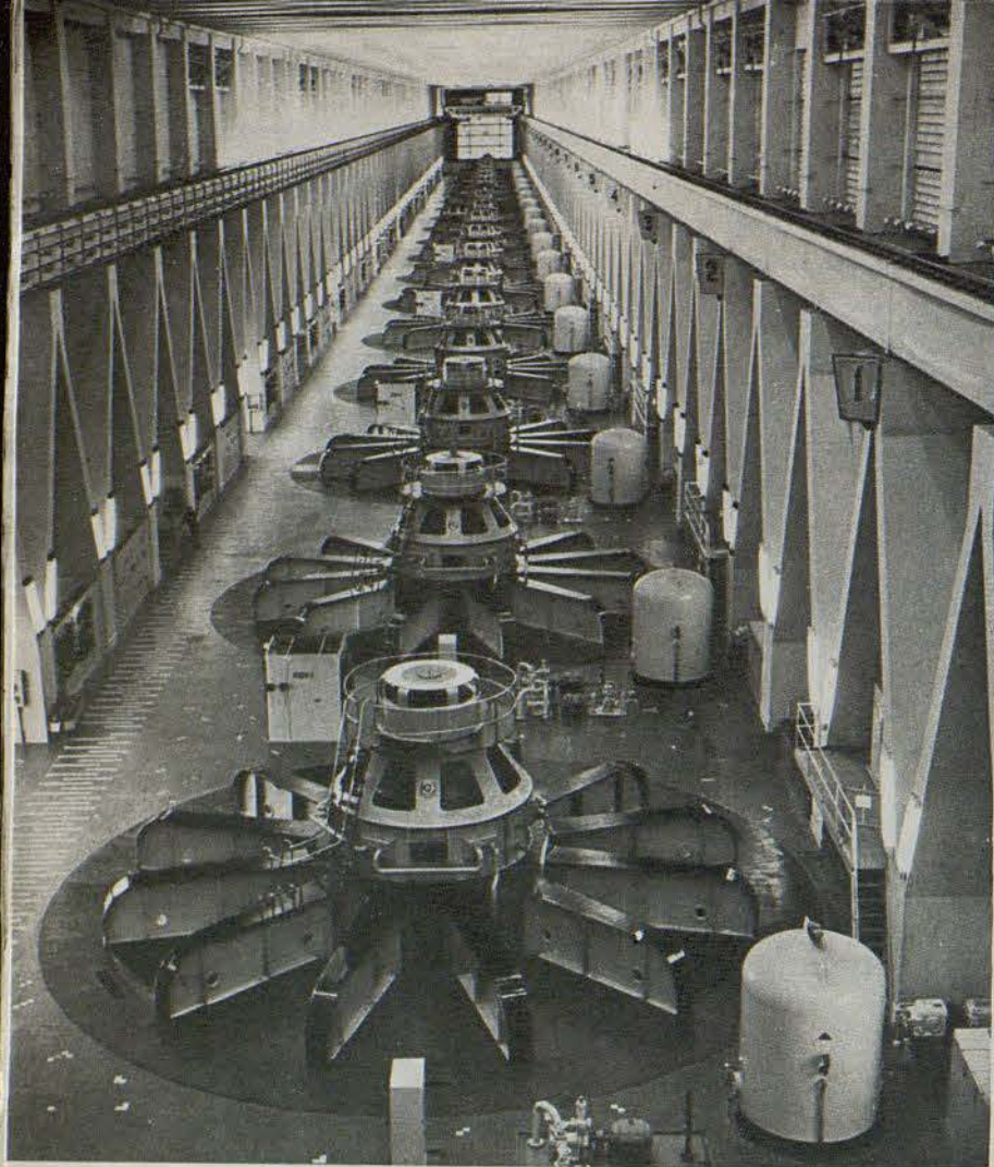
Машинный зал Братской ГЭС.
