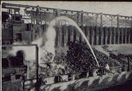
I forni per la produzione del coke.
