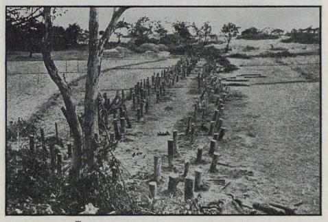
TREE STUMPS MADE CRUDE, TOUGH TANK TRAPS
