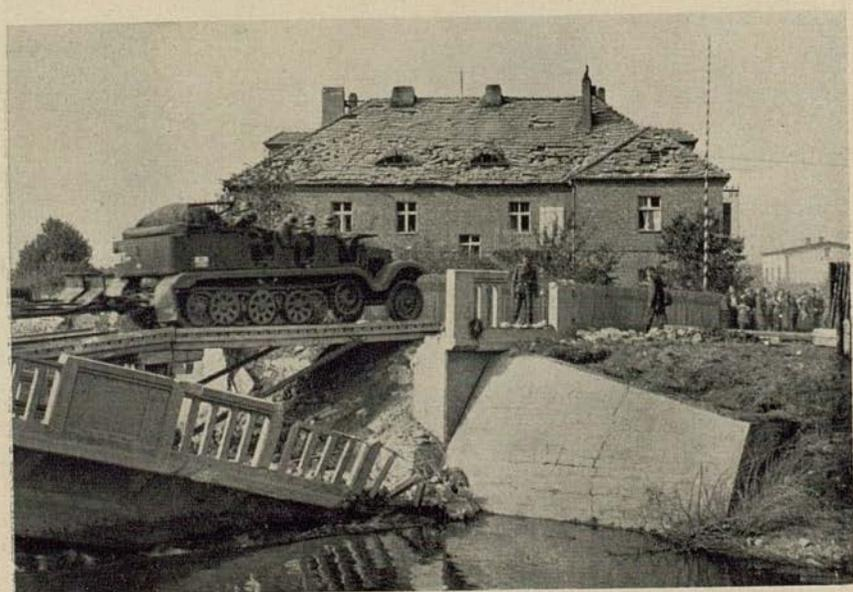
**Behelfsbrücke über die Malapane bei Stahlhammer**
