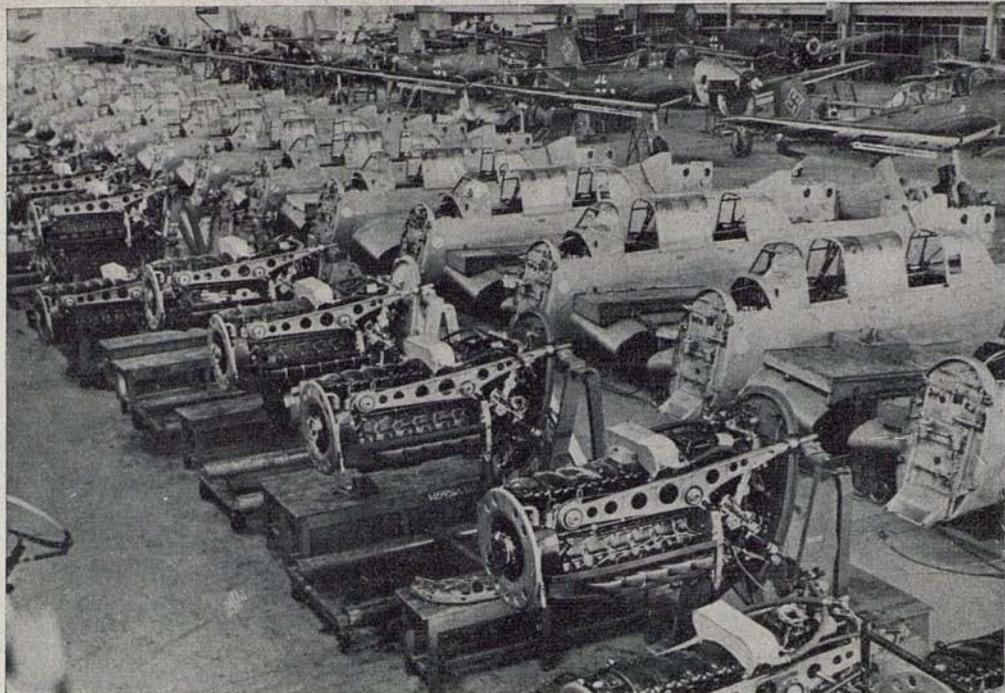
Esta es una de las naves de las fábricas de aviones Junkers. Alineados, en primer término, os motores JUMO 211, prestos para ser colocados en los Stukas que les esperan detrás.
