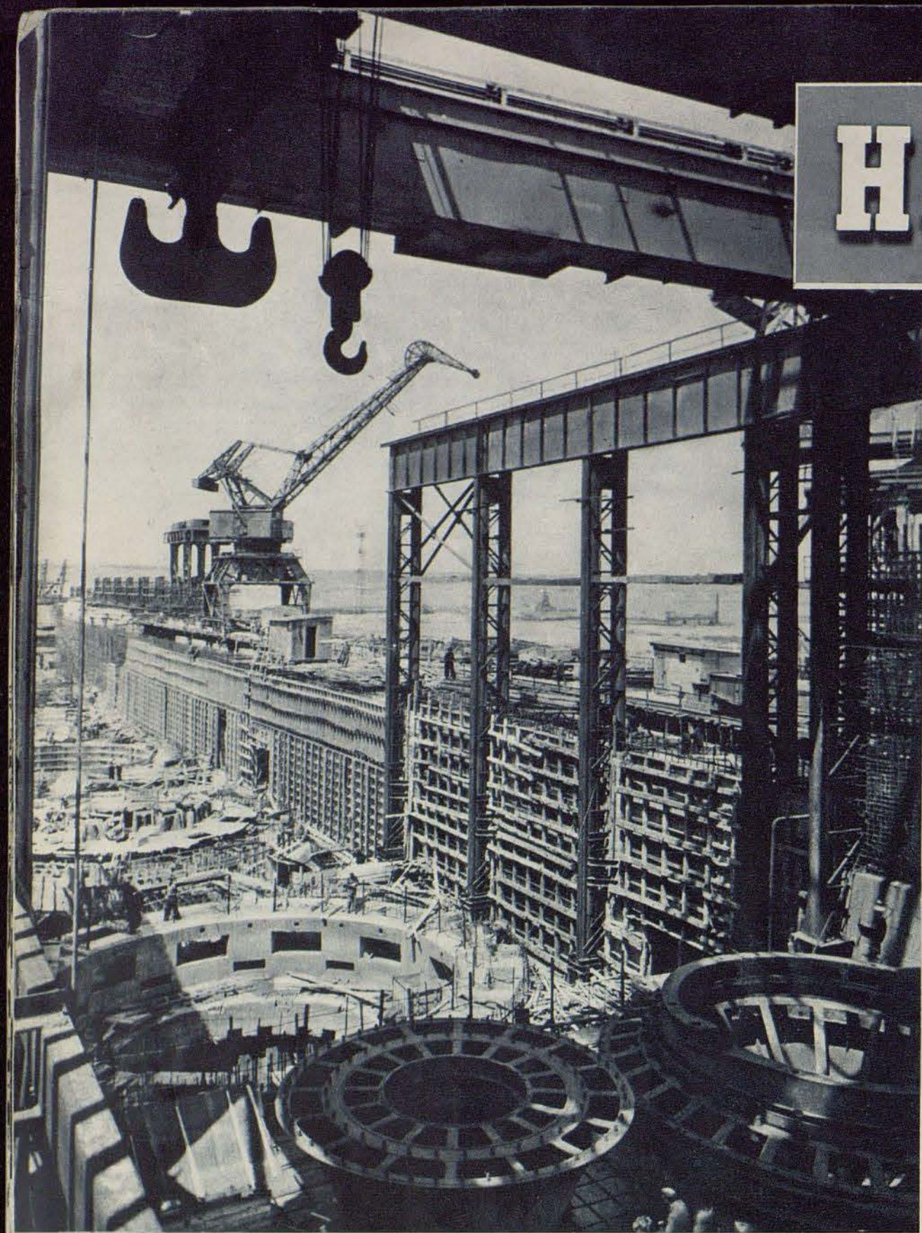
Монтаж турбин Каховской гидроэлектростанции.
