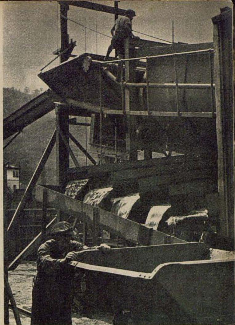
*Et ici les pierres, le limon, le sable sont lavés aussi longtemps que l'or n'y reste plus que sous la forme de paillettes luisantes et de noisettes minuscules*
