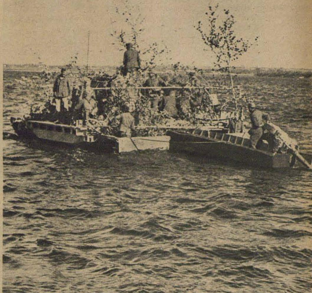
**Les canons suivent déjà.** Des pionniers ont lié les bateaux deux à deux; ils ont ainsi construit un ponton. On y amène les canons, camouflés de branchages et d'arbustes qui les dissimulent aux vues aériennes. Lentement propulsés par les moteurs des embarcations, ils poussent vers l'avant. La traversée par l'artillerie a décidé du succès de la tentative. Une importante tête de pont sur la rive est du Dnieper a été constituée
