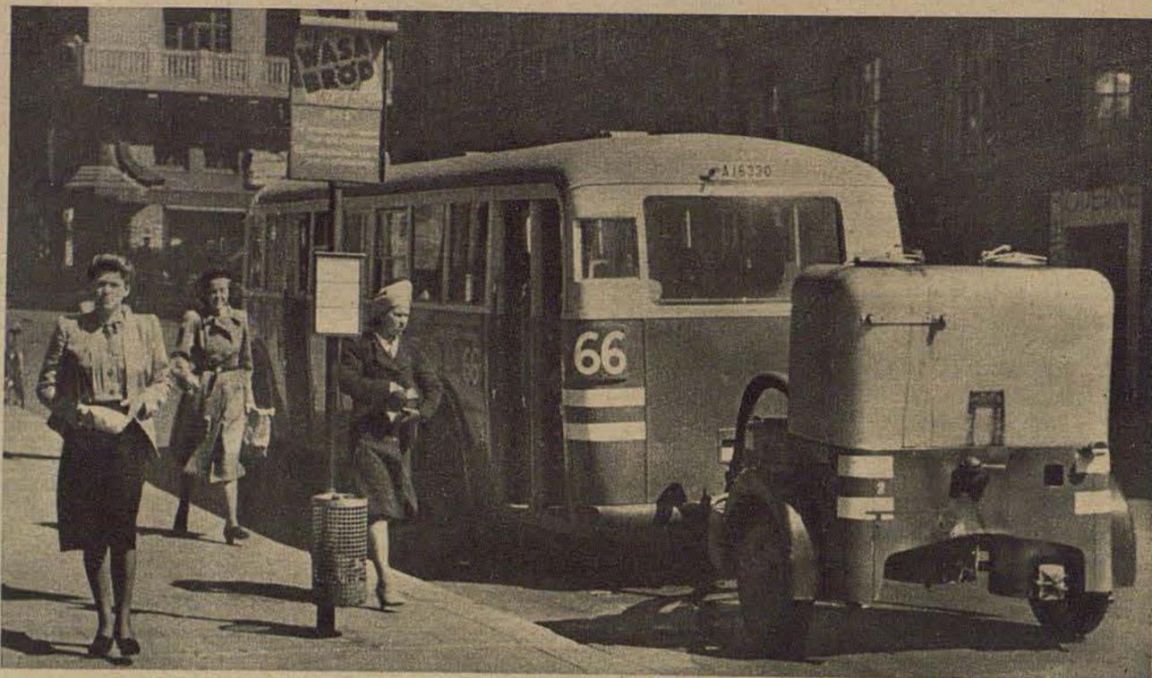
Un dépôt de «Gen-Gas» dans une rue de la capitale suédoise. On a remplacé l'essence par du charbon de bois, qu'on vend, non pas au poids, mais au sac, équivalant à 100 litres de carburant
