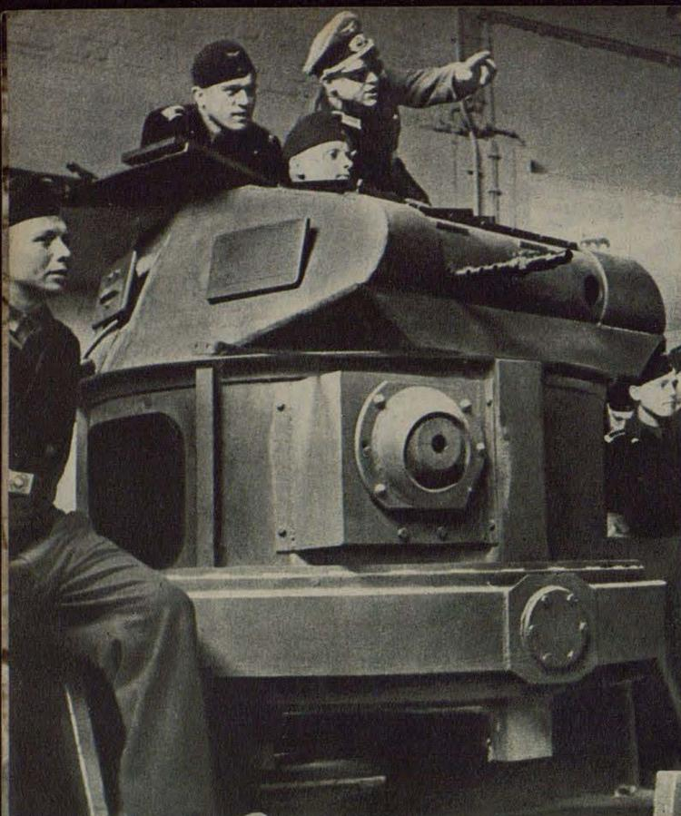
Sur la «plate-forme à cahots». C'est sur elle que sont mis à l'épreuve le calme et la sûreté de tir du canonier de char. La «machine à secousses» rend avec un naturel parfait tous les cahots éprouvés dans les accidents de terrain. Vu la nature imprévisible des à-coups, il faut vraiment beaucoup d'habileté pour conserver bon ail et main sûre.
