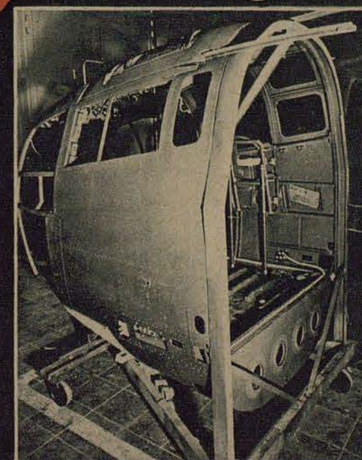
C A la phase suivante, le poste de pilotage, amené tout prêt, est monté.
