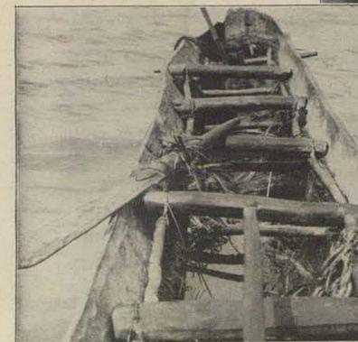
Das Boot ist ein Einbaum mit aufgesetztem Wellenbrecher.
