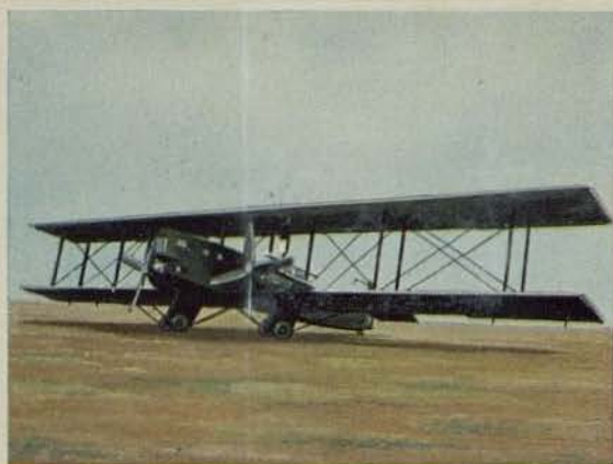
Polnischer Nachtbomber „Farman F 160“. Motorleistung 2 \times 500 PS. Höchstgeschwindigkeit 180 km. Flugweite 1000 km. Bombenladung 2000 kg
