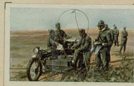
Italienische fahrbare Telegraphenstation. Sie begleitet die Kerntuppe auf dem Vormarsch und übermittelt die Befehle an das und von dem Oberkommando
