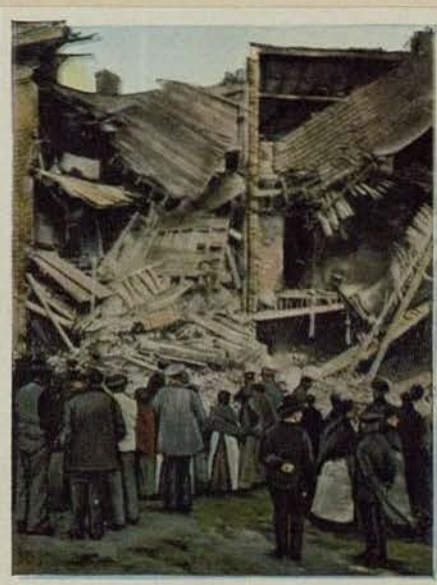
Zerstörtes Wohnhaus durch Einschlag einer 50 kg Minenbombe
