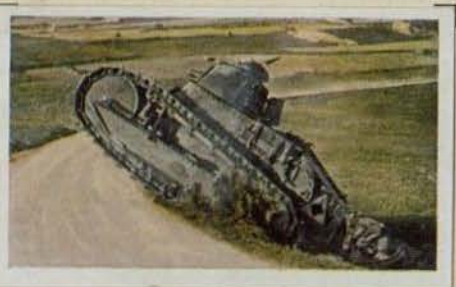
Französischer Renault-Tank im Gefecht. Diese Tanks besitzen eine 20 mm Panzerung und werden stets in Verbindung mit Infanterie eingesetzt werden
