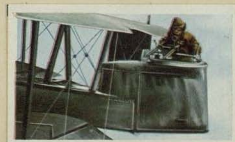
Heckstand des englischen Nachtbombers „Vickers Virginia“. Der MG-Schütze im Heckstand hinter dem Leitwerk verteidigt die Angriffe aus dem Rückhalt
