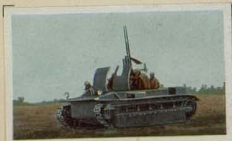
Englische Fliegerabwehrgeschütze auf Großkampfwagen montiert. Kaliber 7,62 cm. Schußweite 11 km
