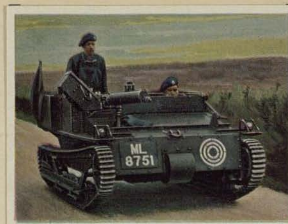
Engl. 2-Mann-Tank „Carden-Lloyd-Mk. VI“. Bewaffnung 1 Vickers- MG. oder 1 x 47 mm Kanone. Munition 3500 Stüd. Panzerung 8 mm
