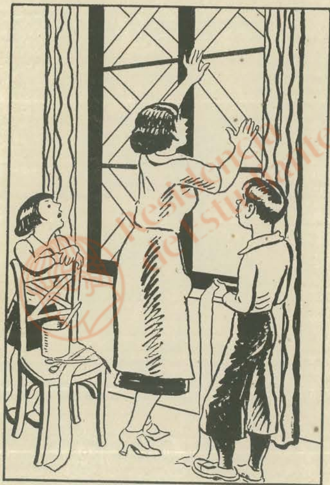
Fig. 13.—Protecció de vidres. A l'aguait amb les puntes, les quals s'han d'enganxar al bastiment de fusta.
