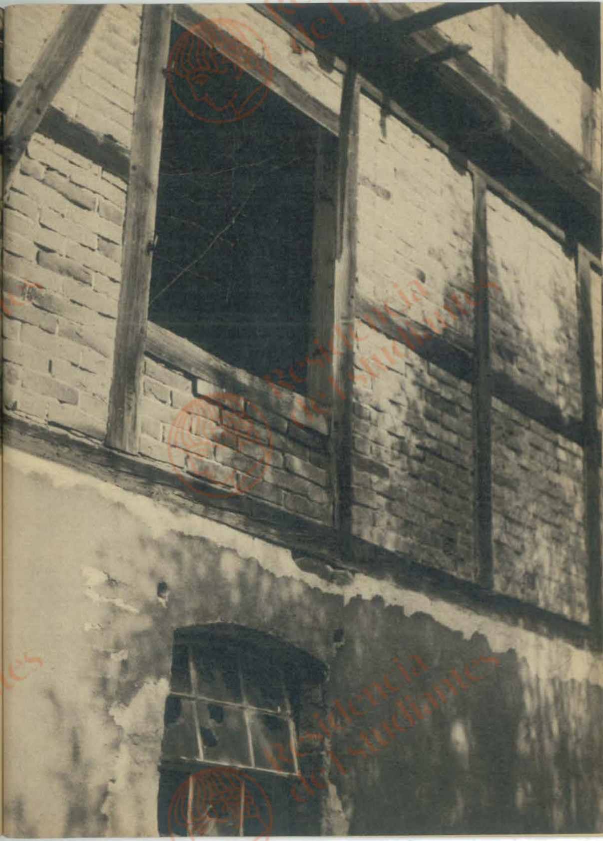
70. Durch eine Scheune der Asbacher Mühle geht die Zonengrenze hindurch. Selbst die leeren Fensterhöhlen sind verdrahtet.
