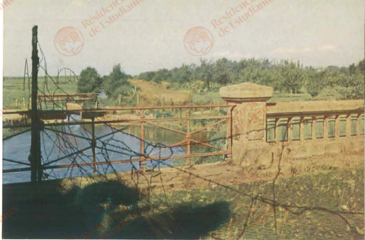
Straßensperre auf der Brücke über die Aller bei Büstedt.
