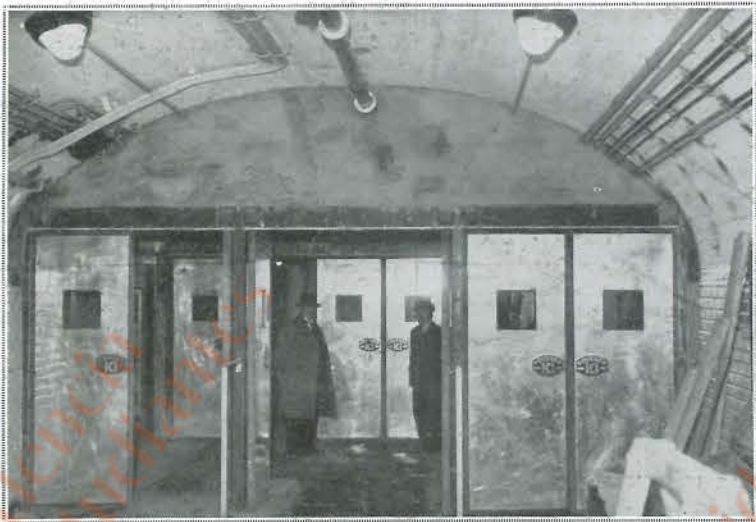
A la station du métropolitain de la Place-des-Fêtes. A gauche, l'entrée du sas de l'abri souterrain ; à droite, le ventilateur d'aération.
