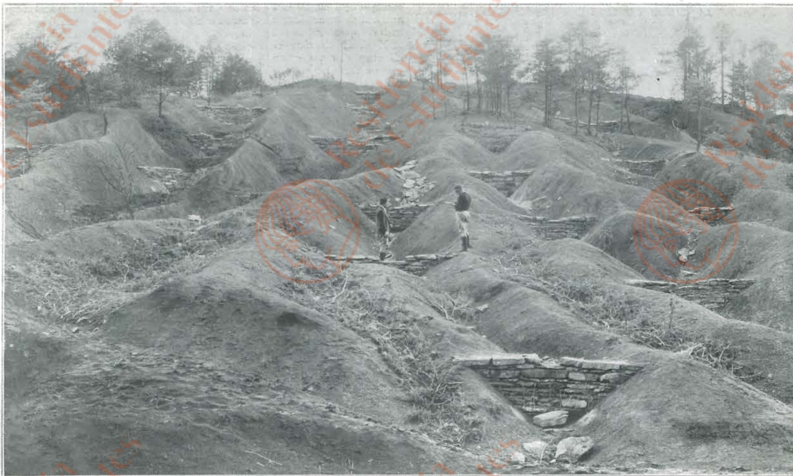
Nombreux petits barrages établis par les volontaires des camps de travail sur les collines du Tennessee afin d'arrêter l'érosion qui ravage le pays.
