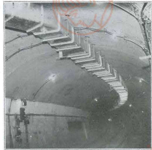
Prise d'air desservant l'abri souterrain de la Place-des-Fêtes.
