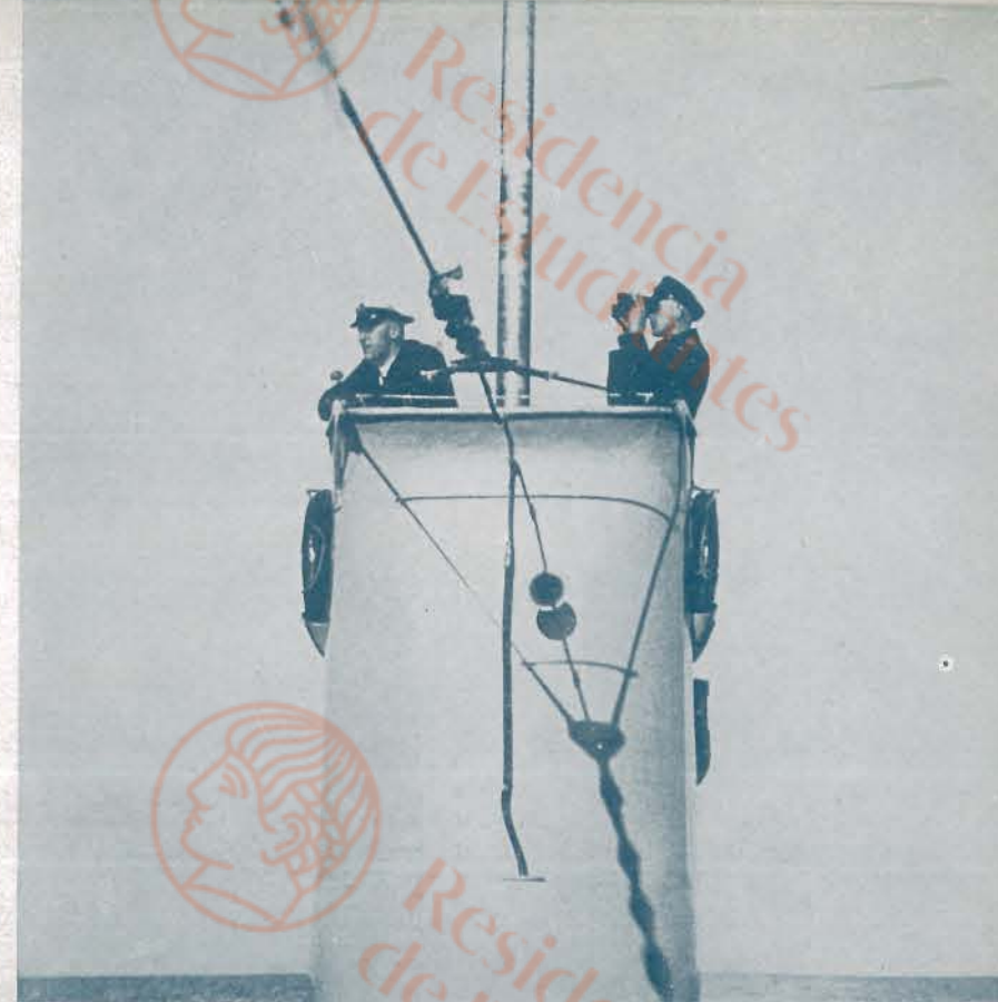
Kommando- turm mit aus- gefahrenem Schnorchel.
