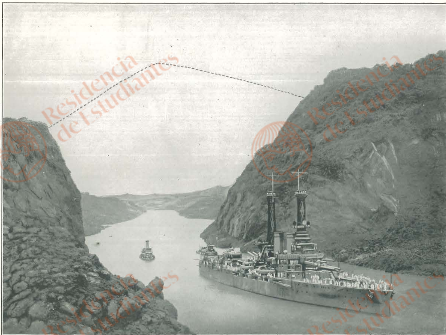
The Culebra Cut. Dotted Line shows Material Removed. Width across top about 3,000 feet. 146 million cubic feet excavated. Panama Canal. El Corte de Culebra. Línea de Puntos Demuestra Material Sacado. Que Ascende a 146 millones de pies cúbicos. Ancho Entre Cumbres Aproximadamente 3,000 pies, Canal de Panama.
