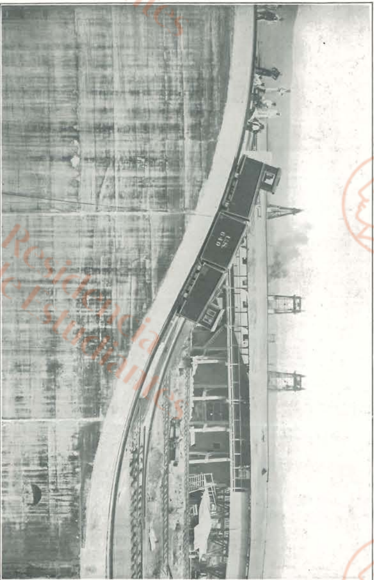
Electric Towing Locomotive in operation at Gatun Locks, Panama Canal. Hilanderas eléctricas funcionando en las esclusas de Gatun, Canal de Panama.
