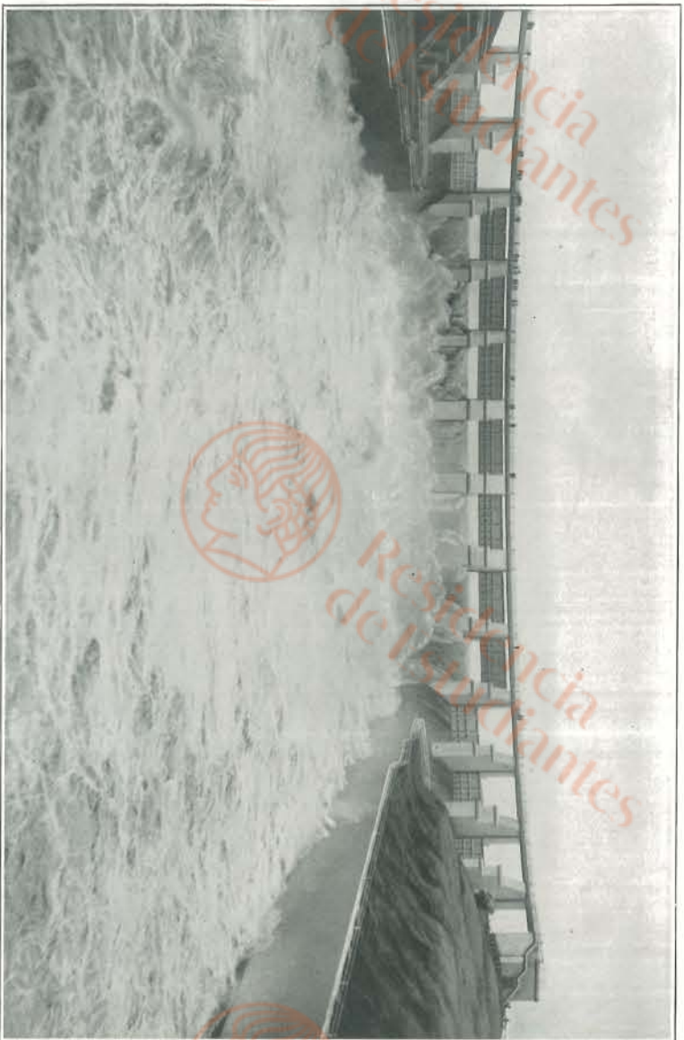
Gatun Spillway in Operation, showing Seven Gates Open. Desague de Gatun funcionando, mostrando siete compuertas abiertas. Canal de Panama.
