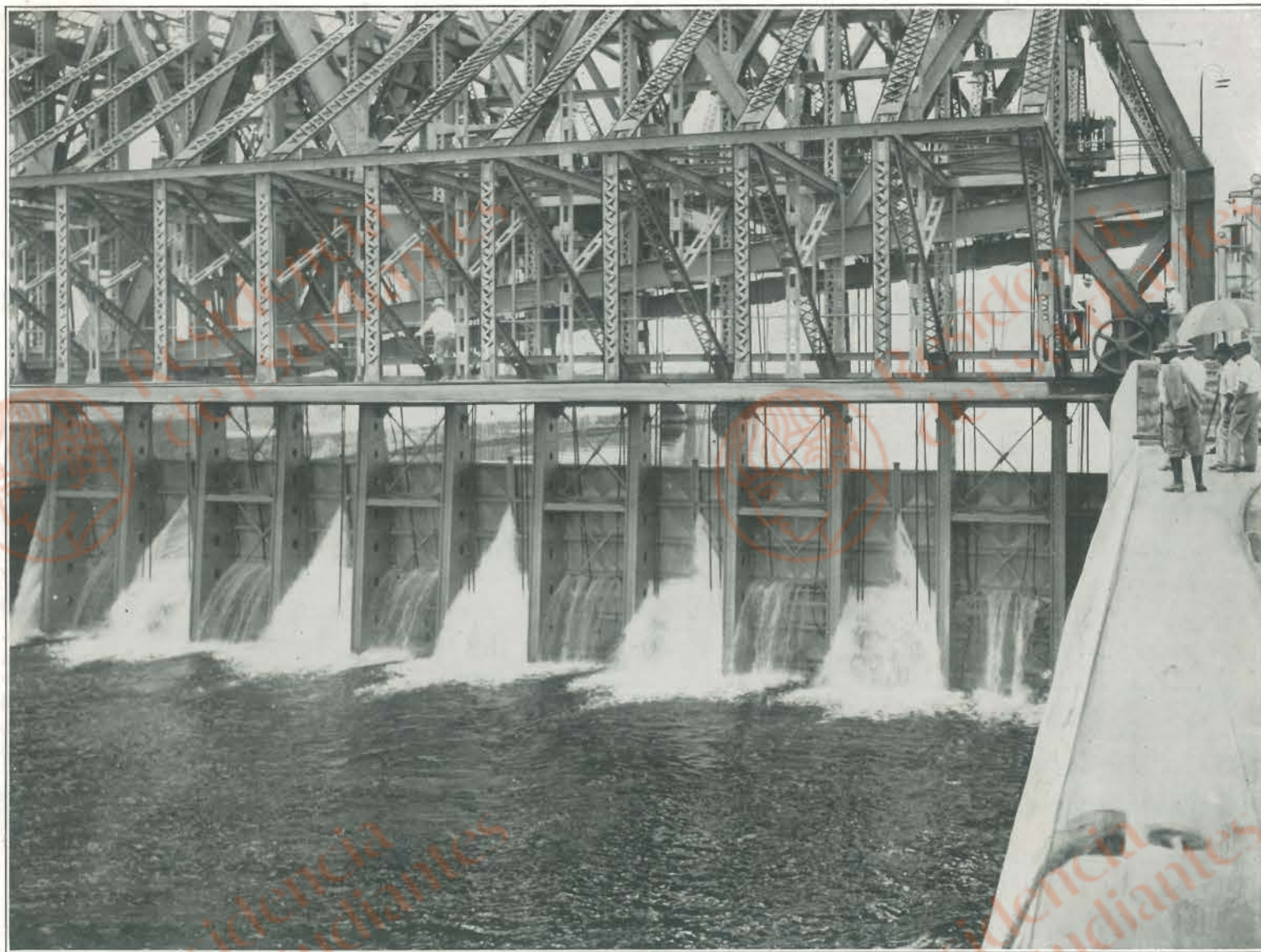
Operating Emergency Dam, Gatun Locks, Panama Canal. Funcionando la represa de emergencia, esclusas de Gatun, Canal de Panama.
