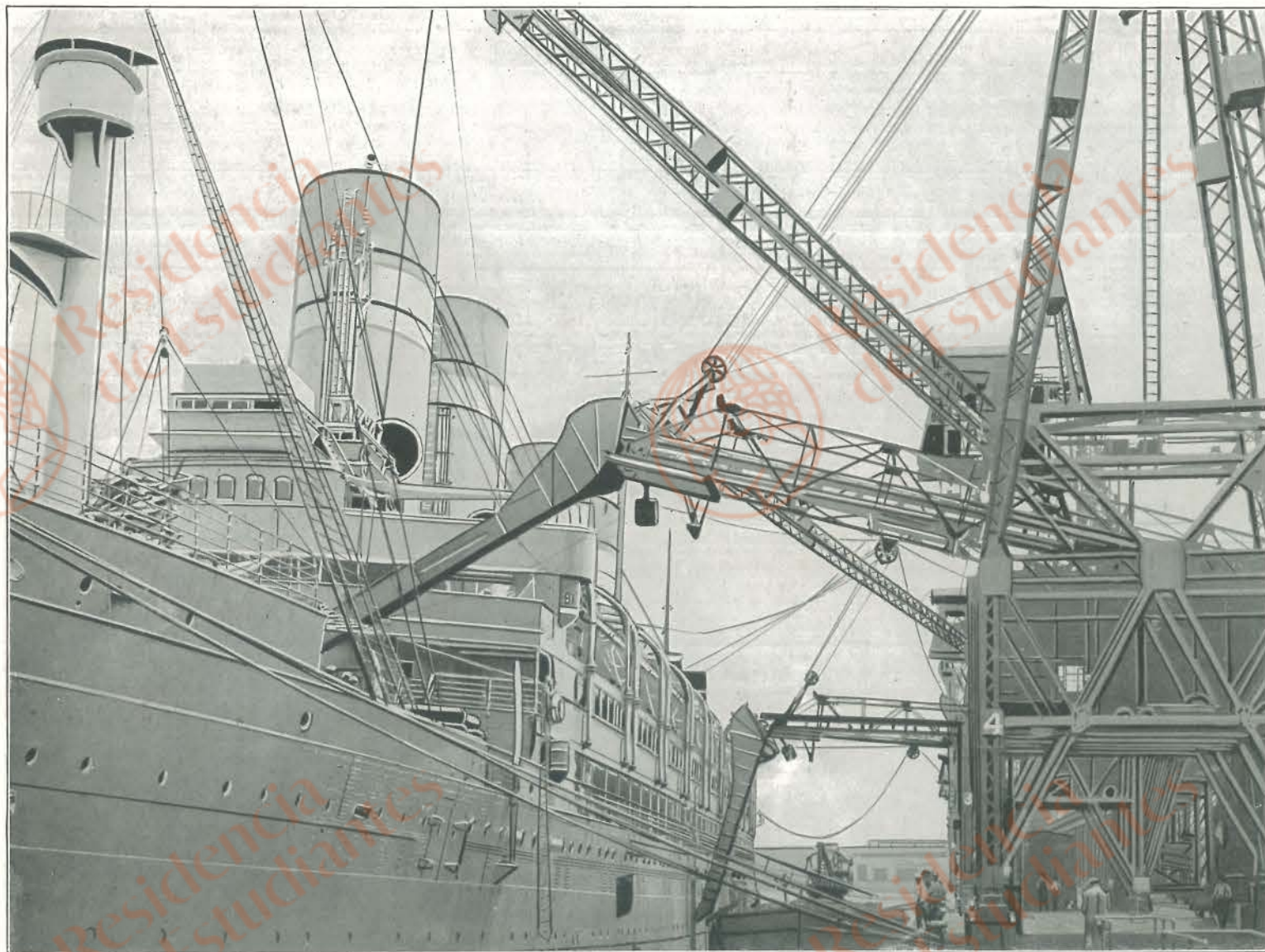
Loading Coal through chutes at the Cristobal Coaling Plant, Canal Zone. Cargando Carbon por medio de Planos Inclizados en la Planta Carbonera de Cristobal, Zona del Canal.
