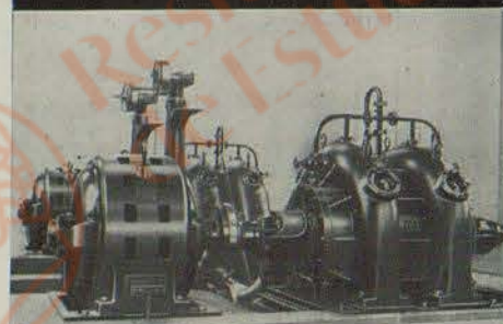
Impianto di pompe sul M. Nera (180.000 litri al minuto a 37 m.)
