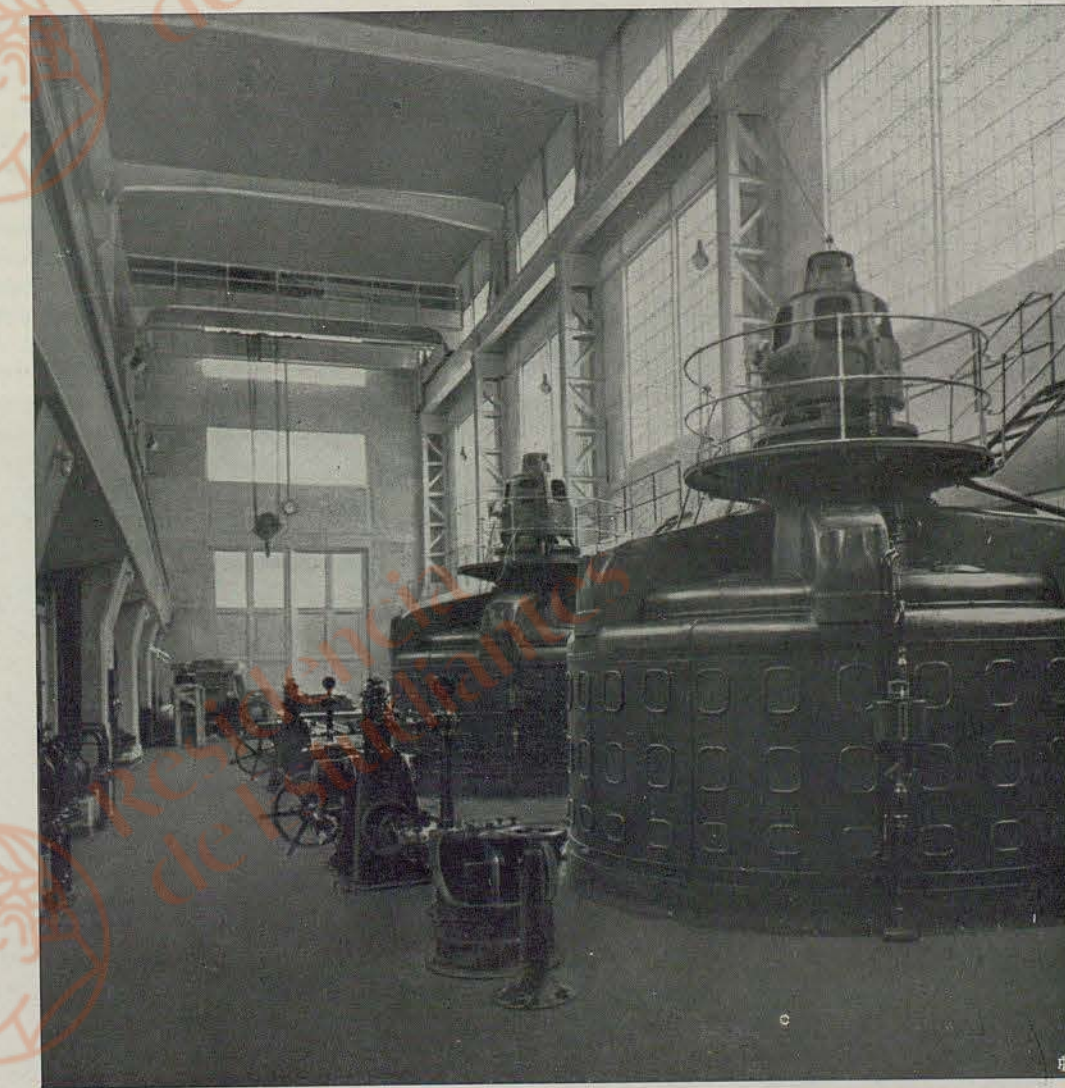
Alternatori trifasi (10.000 KVA - 10.000 Volt - 420 giri) nella Centrale Moline.
