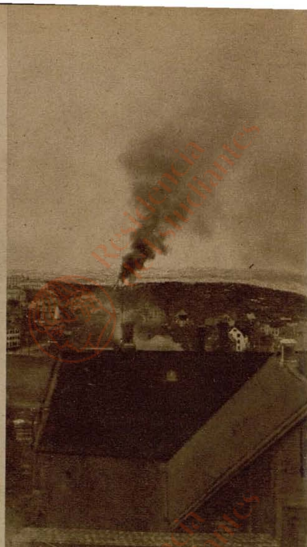
Regimentsjefsboligen, hvor landssvikerer oberst Sundlo hadde sitt kvarter, skutt i brann. Under brannen store eksplosjoner, så jeg måtte holde meg fast da jeg tok bildet, sier «Bilders» korrespondent.
