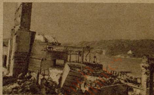
Ruinene av Selvaags hermetikkfabrikk som senere er sprengt bort.
