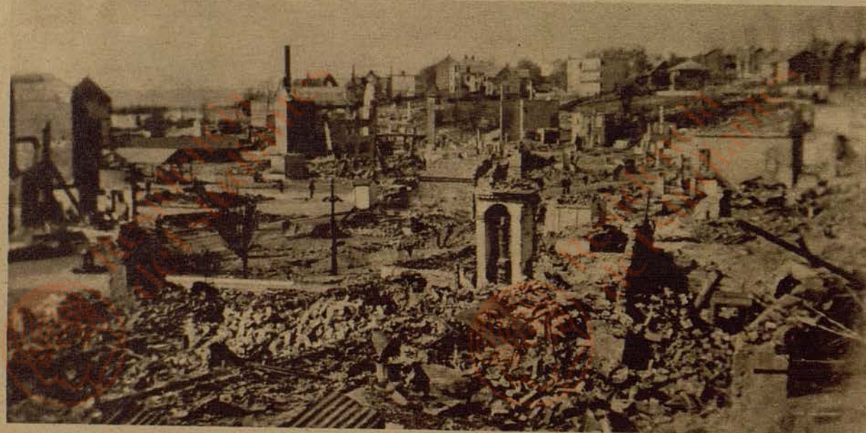
Ytterste del av Molde sentrum. Det som ser ut til å være hus i sentrum, er vesentlig skadde bygg, som man har måttet rive.
