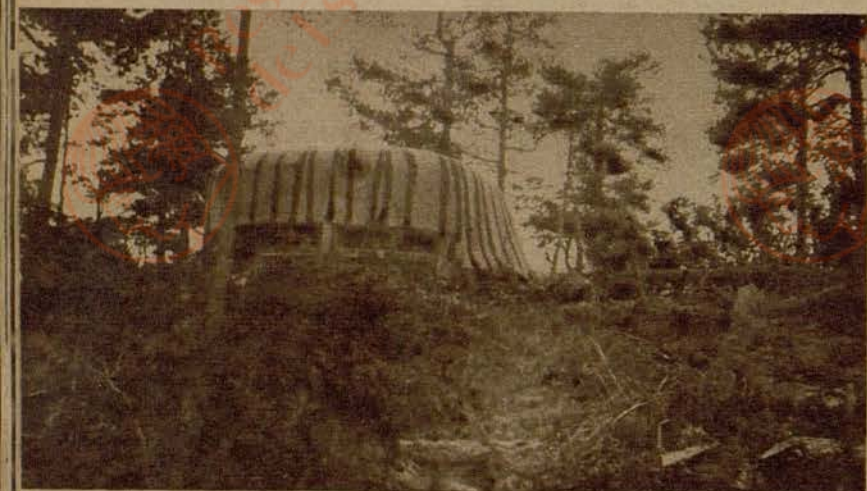
Kommando-tårn. Det var herfra forsvaret ble ledet med så fremragende dyktighet, at forsvaret holdt stand i 23 døgn.
