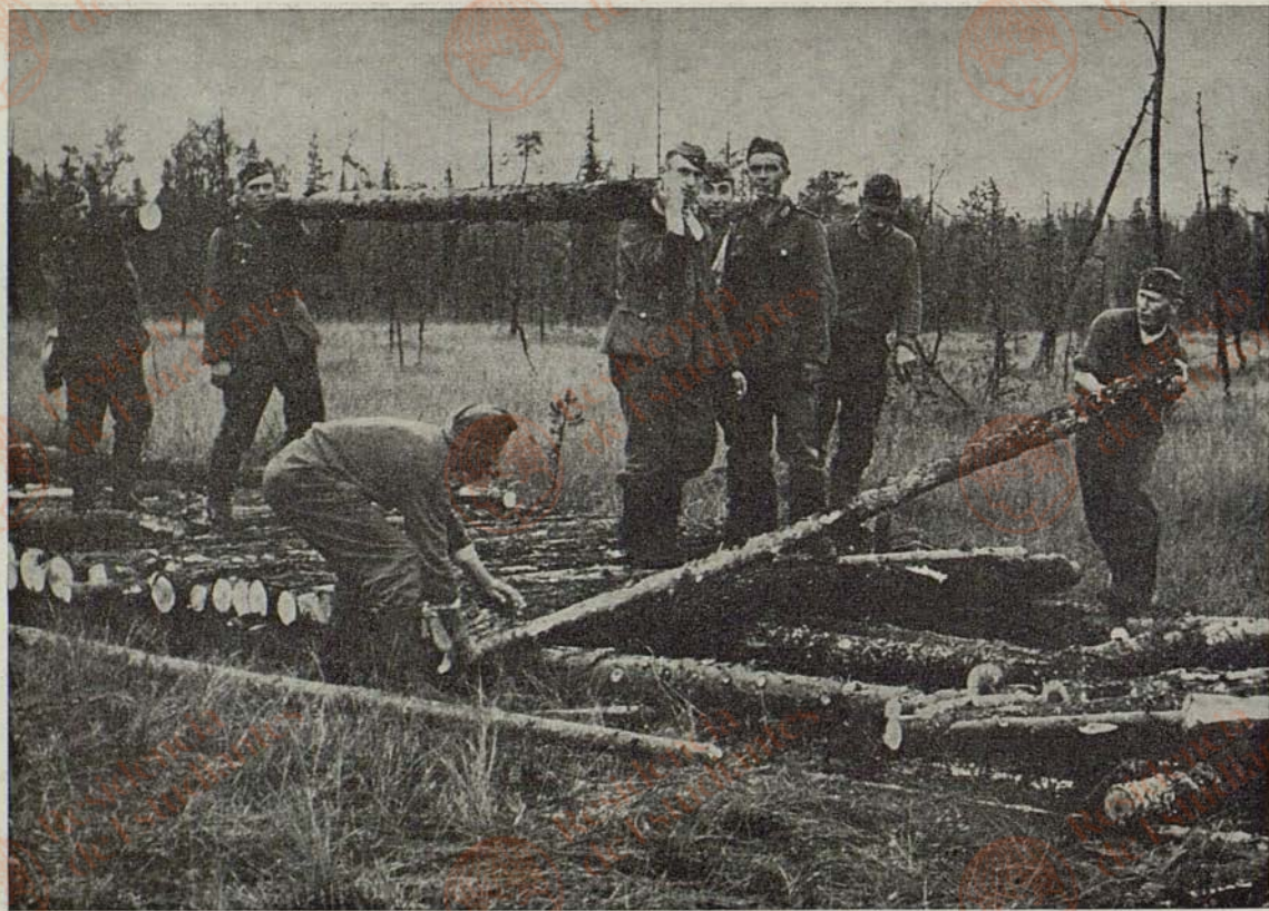
Kilometer um Kilometer bauten die Pioniere Knüppeldämme . . . . .
