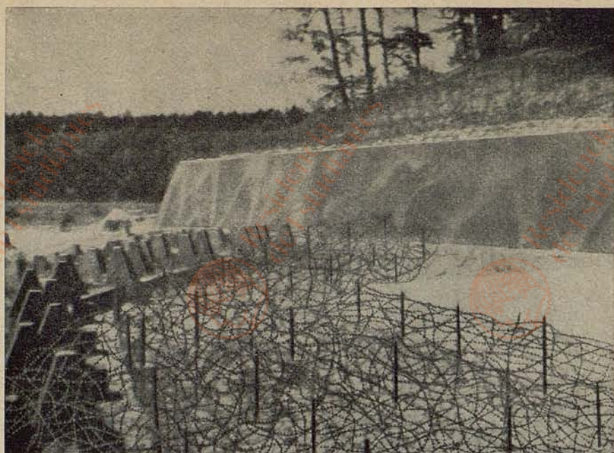
Wo es das Gelände zuläßt, sind zur Abwehr von Kampfwagen hohe Steilhänge angelegt.
