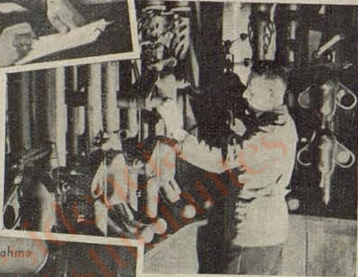
El correo neumático transporta con la rapidez del rayo las noticias e informaciones a la Redacción o a otros departamentos de la editorial.
