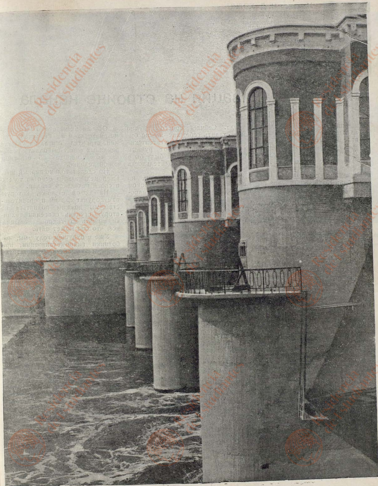
Карамышевская бетонная плотина.
