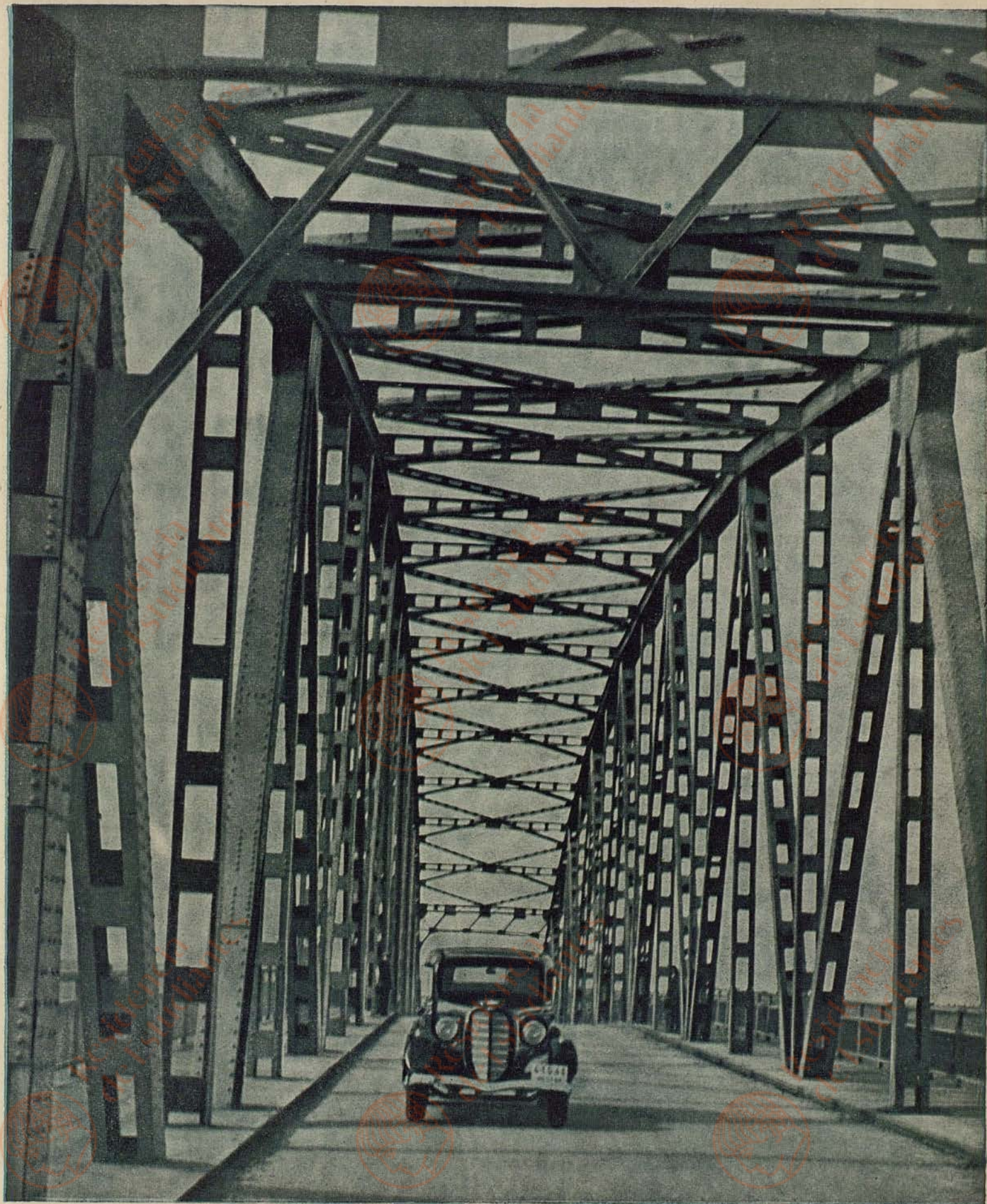
Шоссейный мост через канал в Хлебникове.
