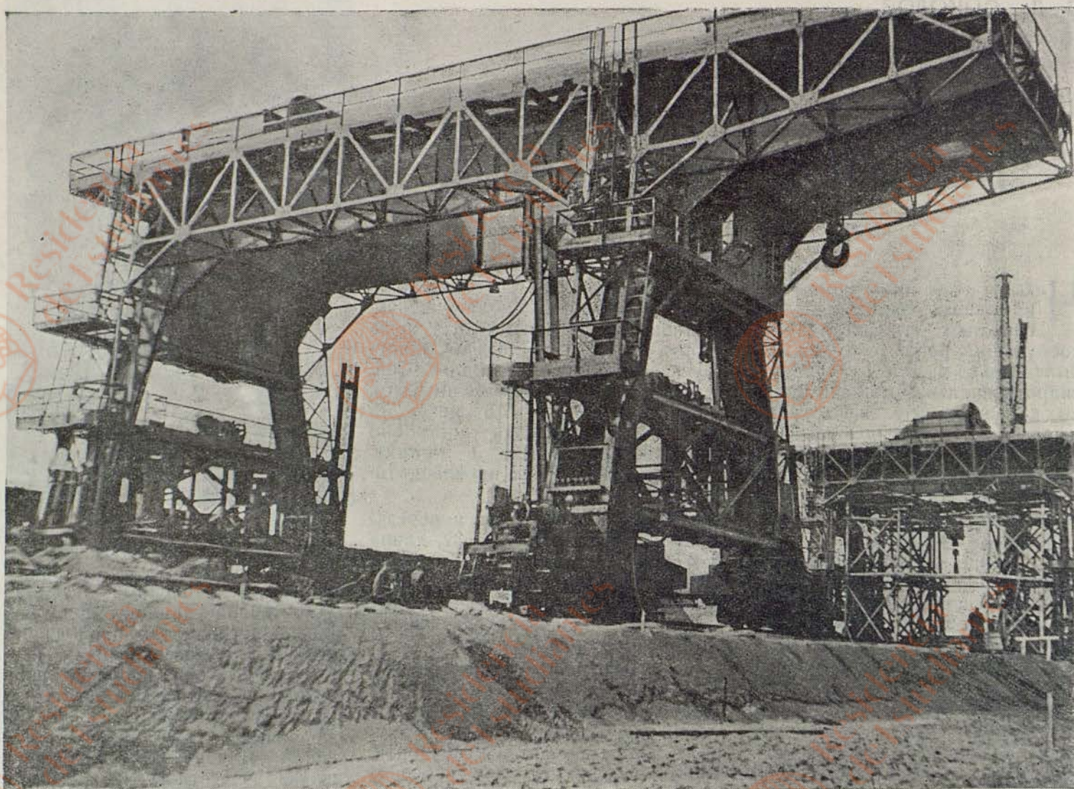
Гиртовый кран на Волжской бетонной плотине
