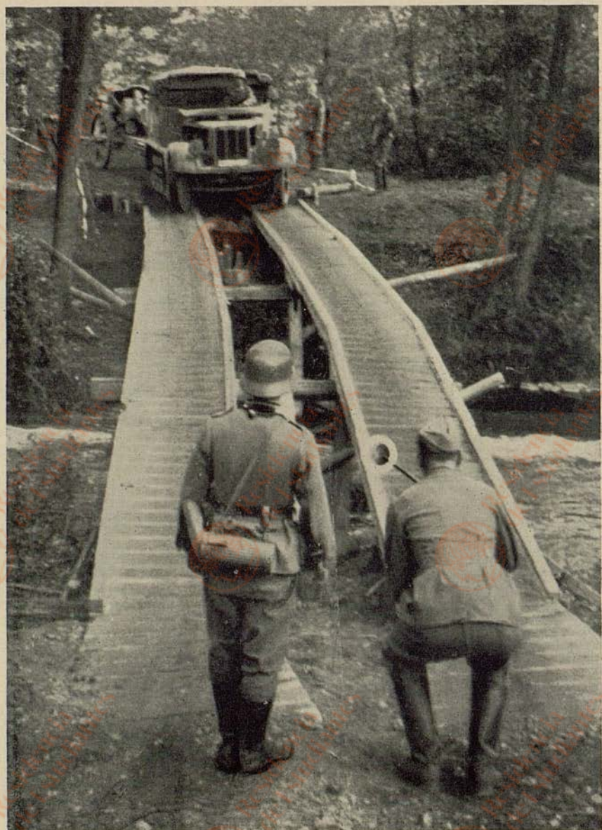
Spurtafelbrücke über die Malapane bei Brusyek
