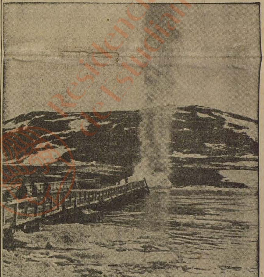
Auch stärkster Eisgang hat den normalen Nachschubverkehr zur Front an der Eismerküste nicht unterbrechen können. Durch zeitgerechte Sprengungen wurden die wichtigen Brücken geschützt. PK-Aufnahme: Kriegsbericht Feldle
