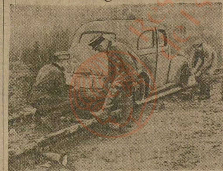
Para salvar las dificultades que la falta de verdaderos caminos crea en Rusia a las fuerzas alemanas, los soldados del Reich, valiéndose de troncos, han montado estas vías, por las que los automóviles discurren encajando sus llantas sin neumáticos en los carriles.
