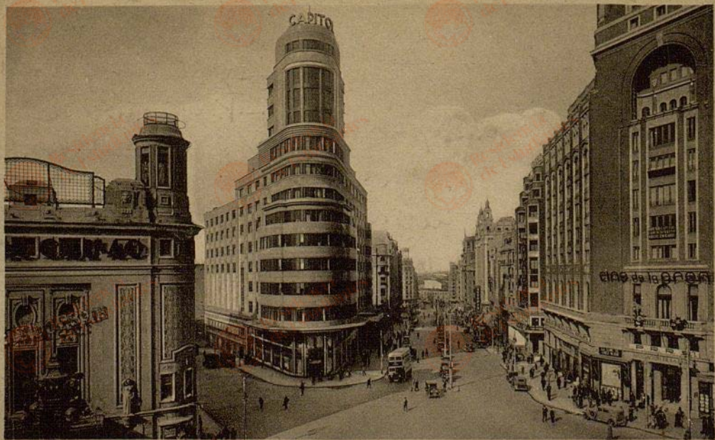
Madrid Cabitol y Avenida de Eduardo Dato
