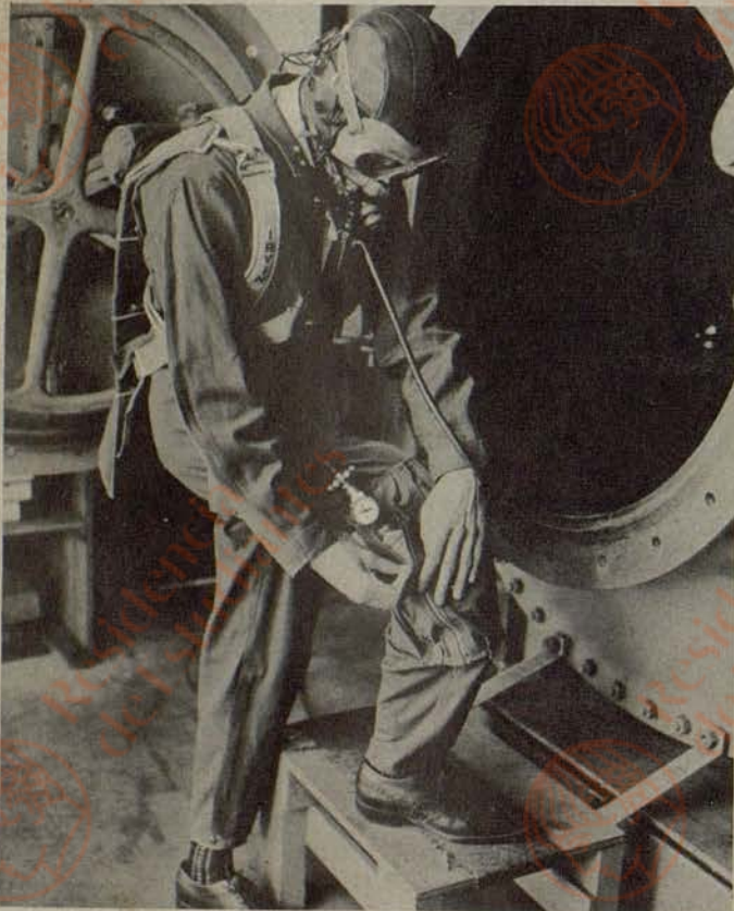
Este piloto de combate a gran altura lleva un balón de oxígeno para usarlo durante el descenso si se lanza desde la estratosfera.
