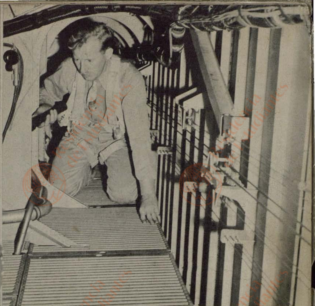
ARRIBA: Tan enormes son las alas del B-19 que permiten reparar el motor en vuelo. Este hombre hace una cuidadosa inspección mientras el monstruo aéreo cruza raudo el espacio.
