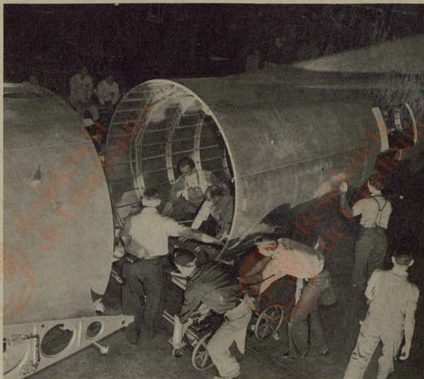
PRODUCCION EN SERIE: MONTAJE DE DOS PIEZAS DE UN AVION DE BOMBARDEO.
