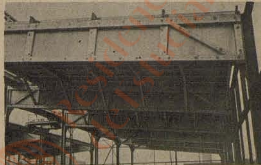
Dachbinder in Sperrholz
