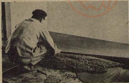
Verlegung von Iporit-Estrich
