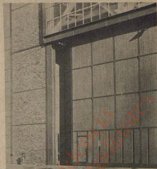
Elektrisch und durch Hand betätigte Schiebefaltoranlage
