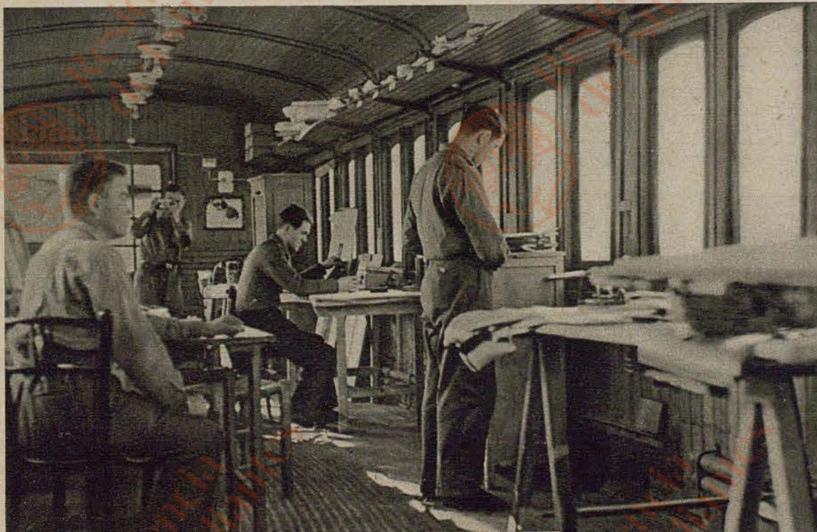
Hat der Fernaufklärer seinen Auftrag erfüllt, so beginnt die Arbeit der Auswerter. Die Einzel- oder Reihen-aufnahmen werden sorgfältig geprüft und notfalls entzerrt, bis man schließlich ein maßstabgetreues Bild der beobachteten Gegend erhält. Die besonderen Verhältnisse in Spanien brachten es mit sich, daß die Auswertarbeit zuweilen in Eisenbahnwagen vorgenommen werden mußte
