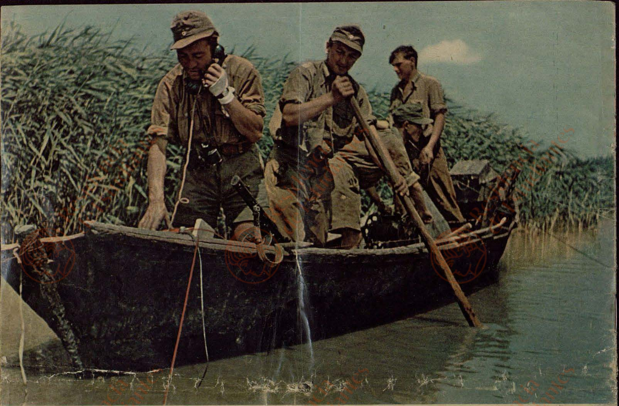
In den Lagunen des Kubanbrückenkopfes: Das Unterwasserkabel zu den einzelnen Stützpunkten wird vom Kahn aus verlegt. Der Truppführer prüft ob die Verständigung in Ordnung ist. Unten: Dicht gedrängt leben die Soldaten auf den wenigen trockenen Stellen im Kubansumpf, sie bilden die vorderste Linie. PK-Aufnahmen: Kriegsberichtler v. Koerber
