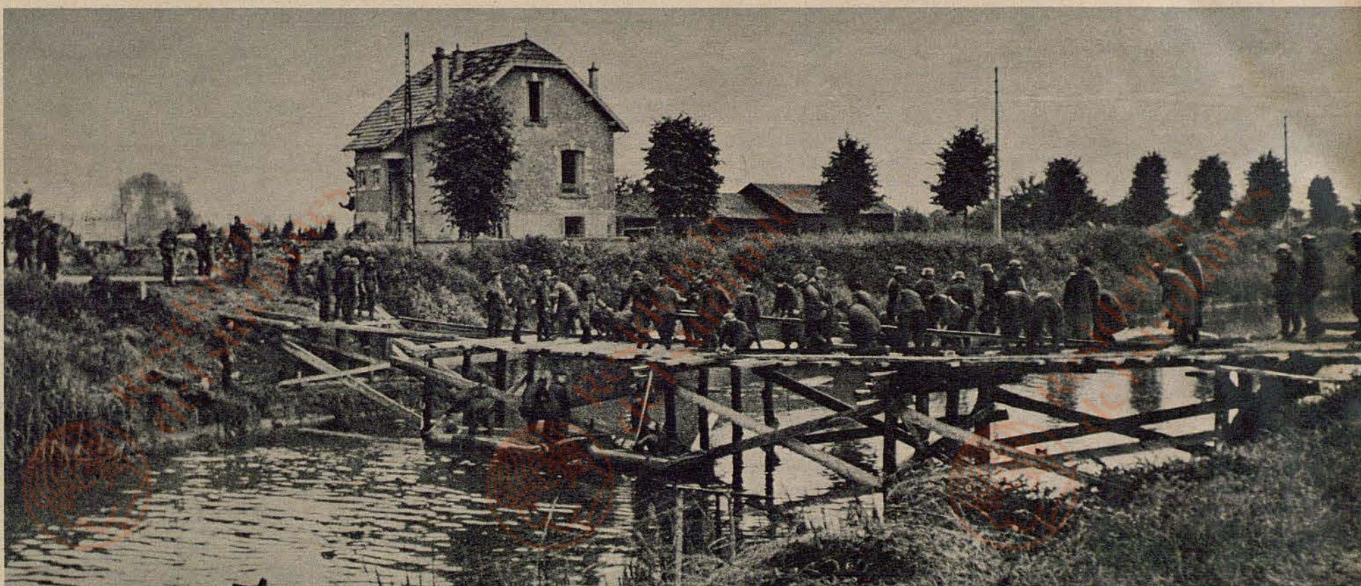
14 h. 45: Les madriers sont placés côté à côté et fixés sur les poutres...
