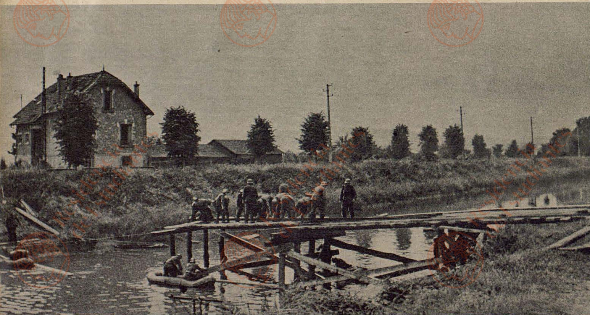
13 h. 45: La seconde palée est mise en place. Sur l'autre rive, une deuxième troupe commence la construction ...
