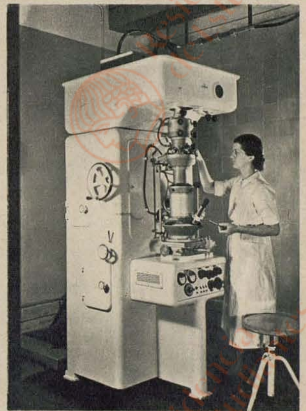
Le supermicroscope Siemens de Ruska et von Borries
