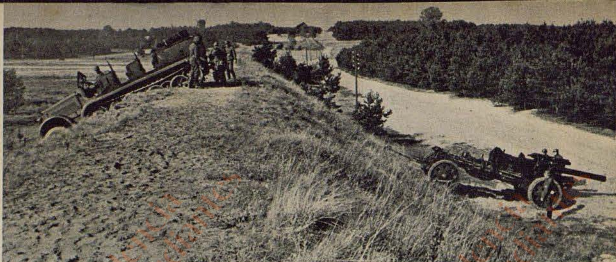
Le conducteur embraye le treuil motorisé: le câble métallique se tend, et tire le canon sur le talus
