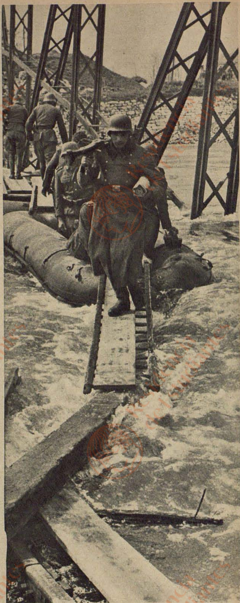
Du caoutchouc au lieu de fer. A l'aide de radeaux, les sapeurs ont construit un ponton provisoire à la place d'un pont détruit sur la Drave. Dix minutes plus tard, la progression continue. — Photo ci-dessous : Il se laisse porter. Un tracteur de chars « porte » le tank lourd jusqu'à la position de départ pour l'attaque
