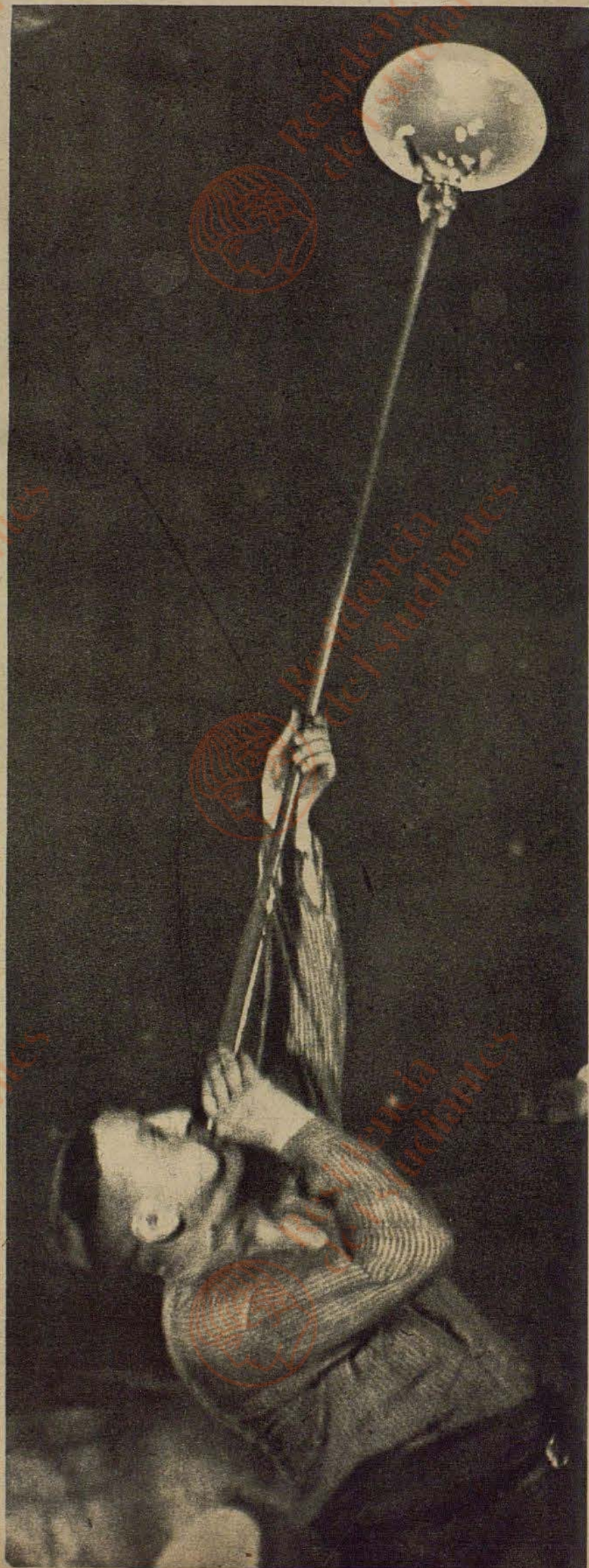
LA LONGUE PIPE... Le souffleur de Lauscha plonge son chalumeau dans le verre en fusion, éprouve la pureté de la pâte, et souffle ensuite une ébauche qu'il métamorphosera finalement en une petite merveille
