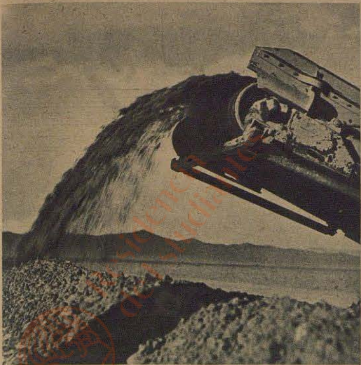
De grands déblaiements ne sont nécessaires que dans les parcours montagneux. Des excavateurs sont à l'œuvre, aspirant et rejetant sable et pierres...
