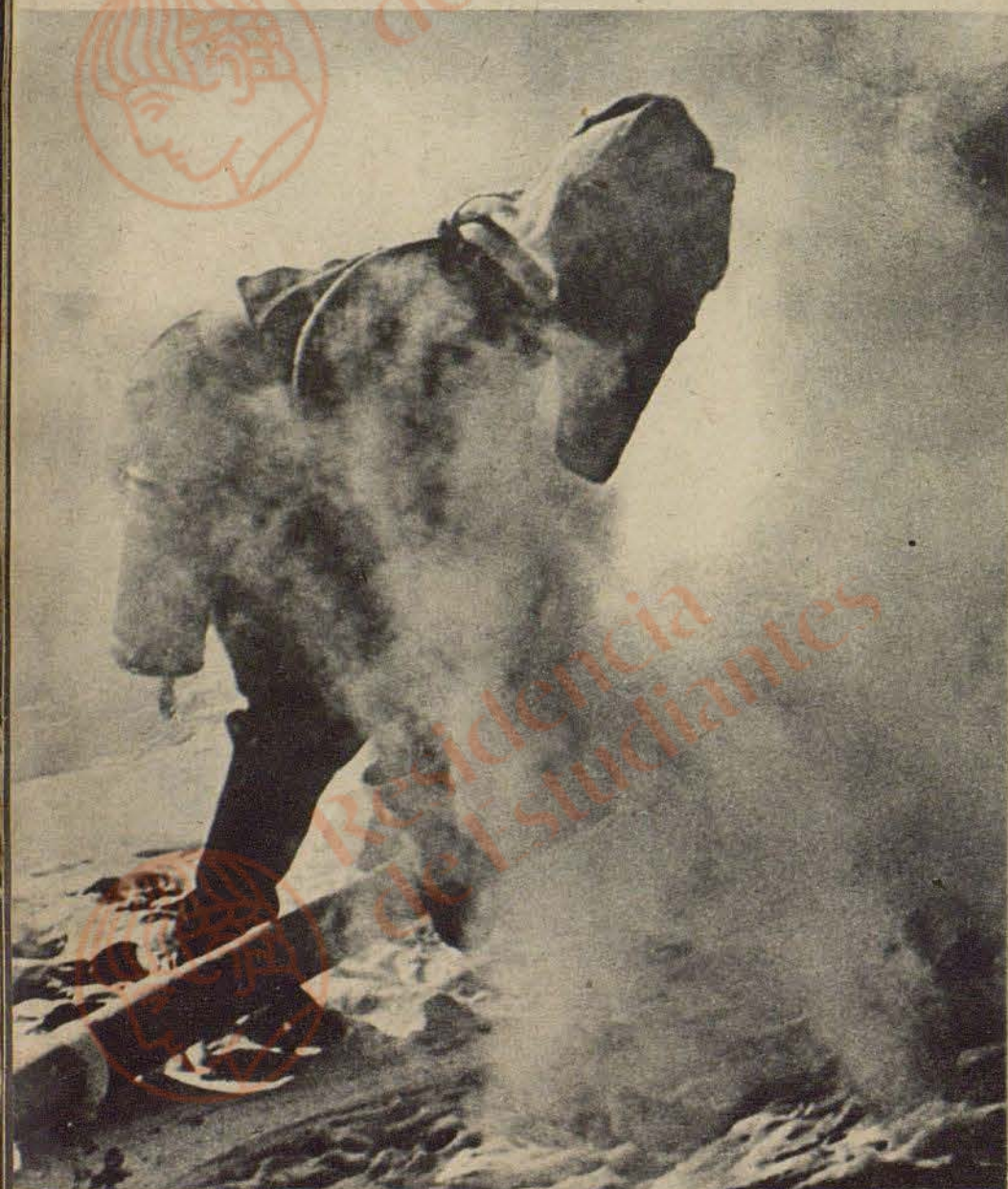
Sous le vent, le porteur approche son tube de mousse sur la surface déjà éteinte, jusqu'au foyer d'incendie. Un manteau d'asbeste et des gants le protègent des flammes; un masque lui permet de respirer.
