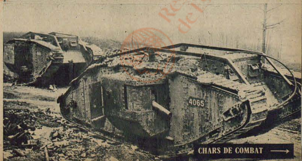
Le tank anglais de 1915. Ce monstre n'offrait qu'un avantage : ses chenilles. Les longs ciseaux qui devaient couper les fils de fer barbelés se révélèrent bientôt inutiles. Là encore, le conducteur est à découvert.
