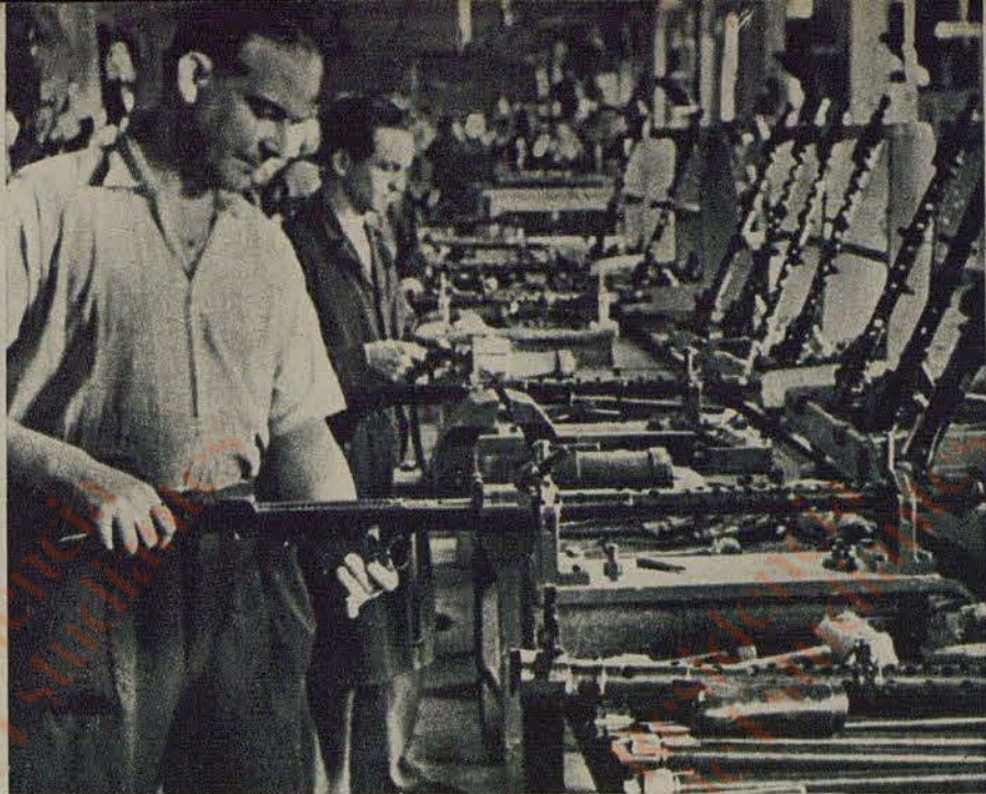
* Mitrailleuses. Les culasses avec leur poignée, et les manchons réfrigérateurs sont adaptés au corps de la machine.
