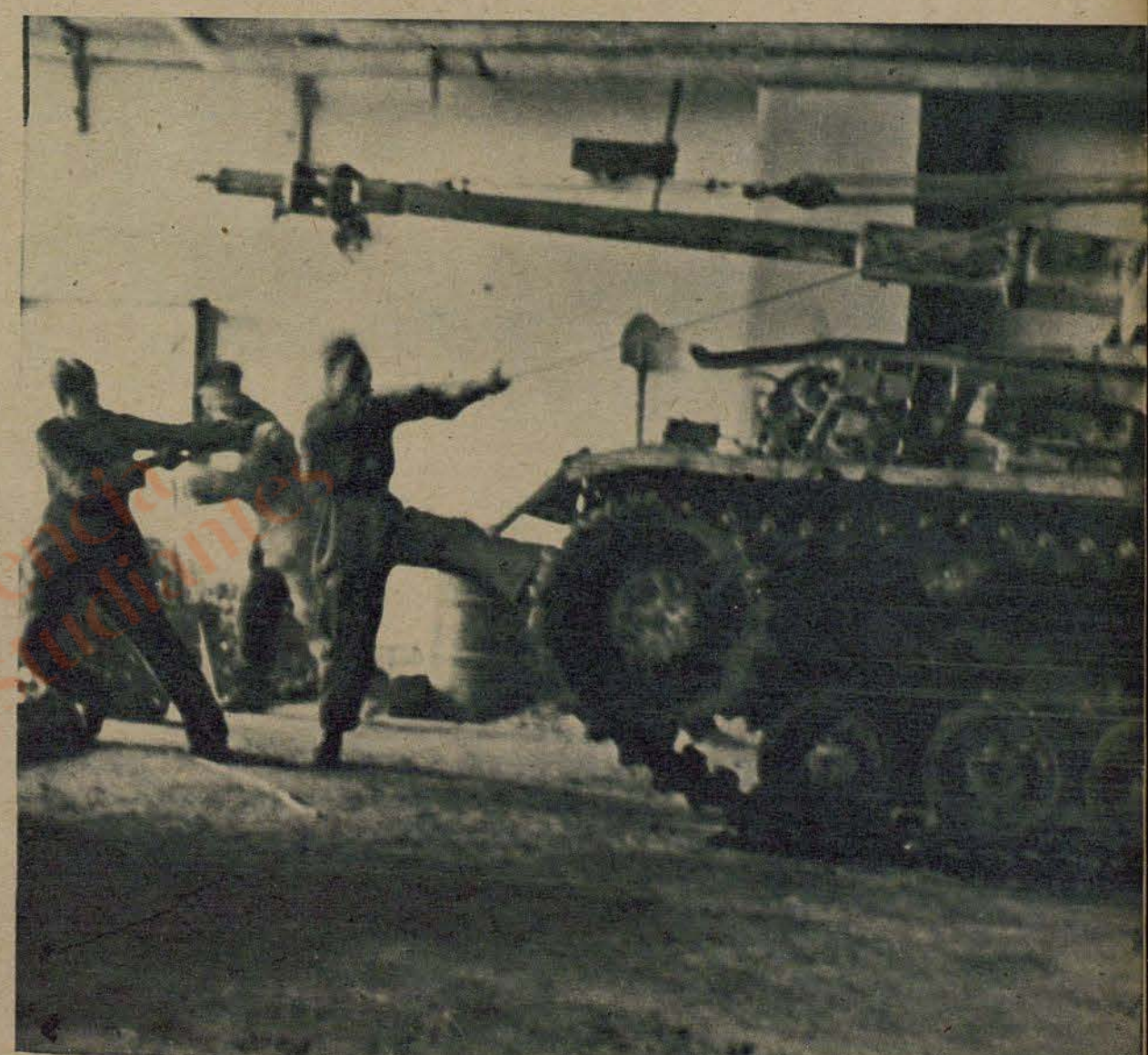
A l'aide d'un palan, on ajuste l'amplificateur de recul sur le tube. Pour les réparations des chars, on dispose d'un grand nombre de spécialistes qui, étant au front, ont l'occasion d'enrichir pratiquement leurs connaissances
