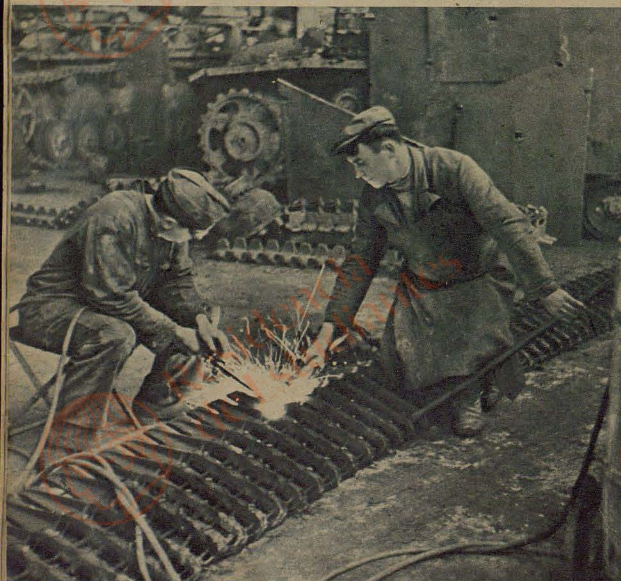
Dans un atelier de réparation, immédiatement derrière les premières lignes, des spécialistes allemands travaillent à réparer les chars endommagés. Des ouvriers du pays les aident à remonter la chenille
