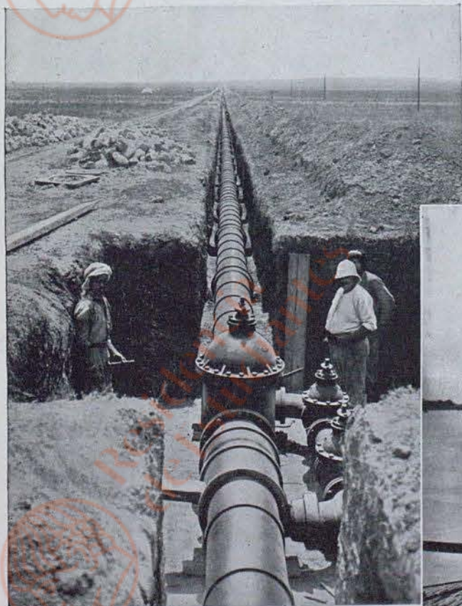
Canalisation en fonte pour l'alimentation de la ville de Sfax. (166 km. de tuyaux de fonte de 325 à 500 \frac{m}{m} ).
