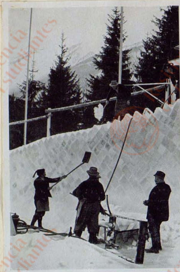
So entstanden die großartigen Kurven der Olympia-Bobbahn! Die Quader aus dem Riessersee werden „zusammengeschweißt“.
