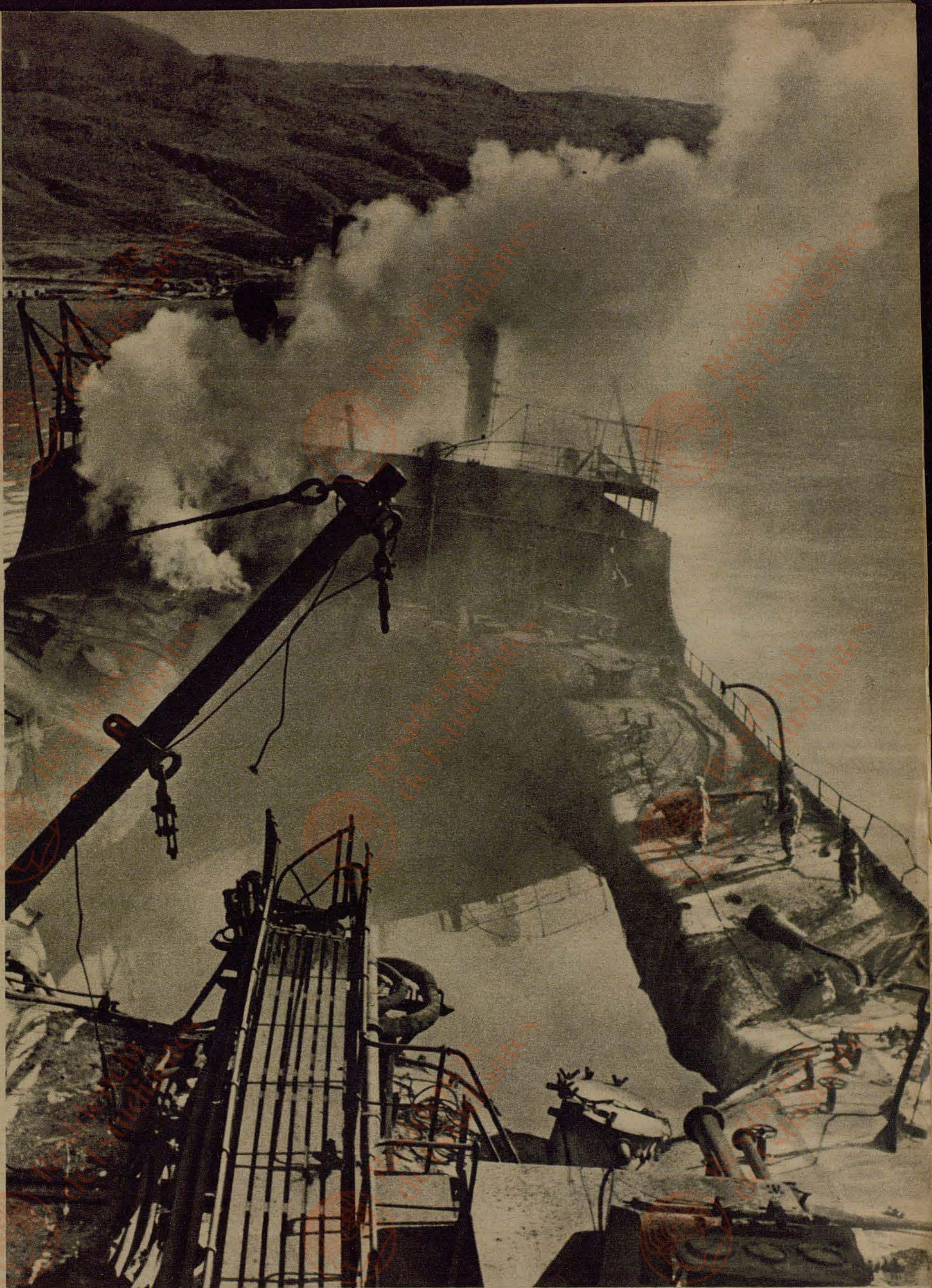
An Bord des qualmenden Tankers wirken die Männer des Prisenkommandos neben dem Bombenkrater des Oberdecks kaum wahrnehmbar klein. Die Bombe hat die zentimeterdicke Stahlplatte glatt durchschlagen und die Bordwände des Schiffes mit gewaltiger Kraft nach außen gedrückt. In dem freigelegten gefüllten Ölbehälter spiegeln sich der Himmel und die zerstörte Reling des Tankers
