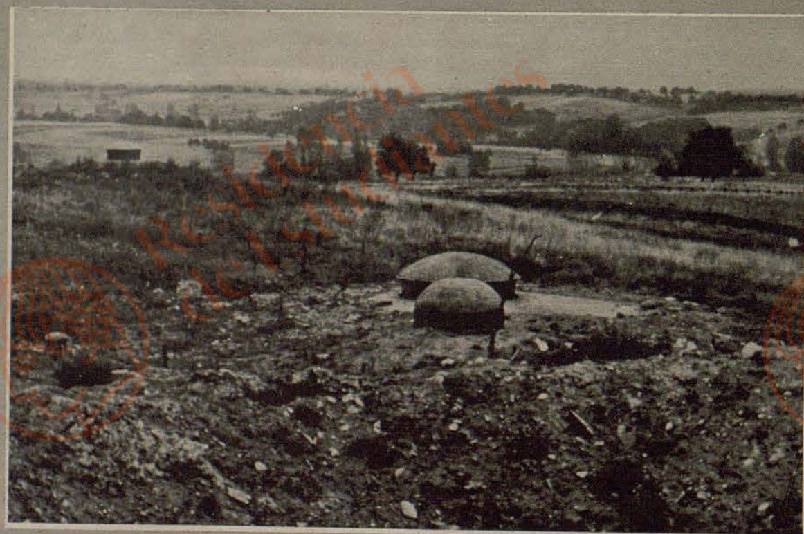
Harmlos fast, wie Pilze, sehen diese Panzerkuppeln aus, sie lassen sich aber auskurbeln und aus ihnen recken sich dann Kanonenrohre.
