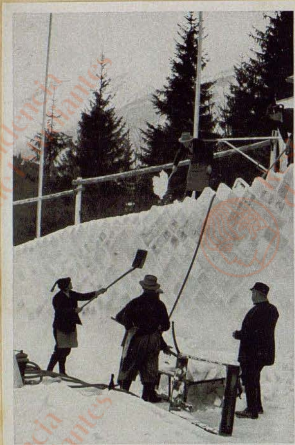
So entstanden die großartigen Kurven der Olympia-Bobbahn! Die Quadern aus dem Riessersee werden „zusammengeschweißt“.
