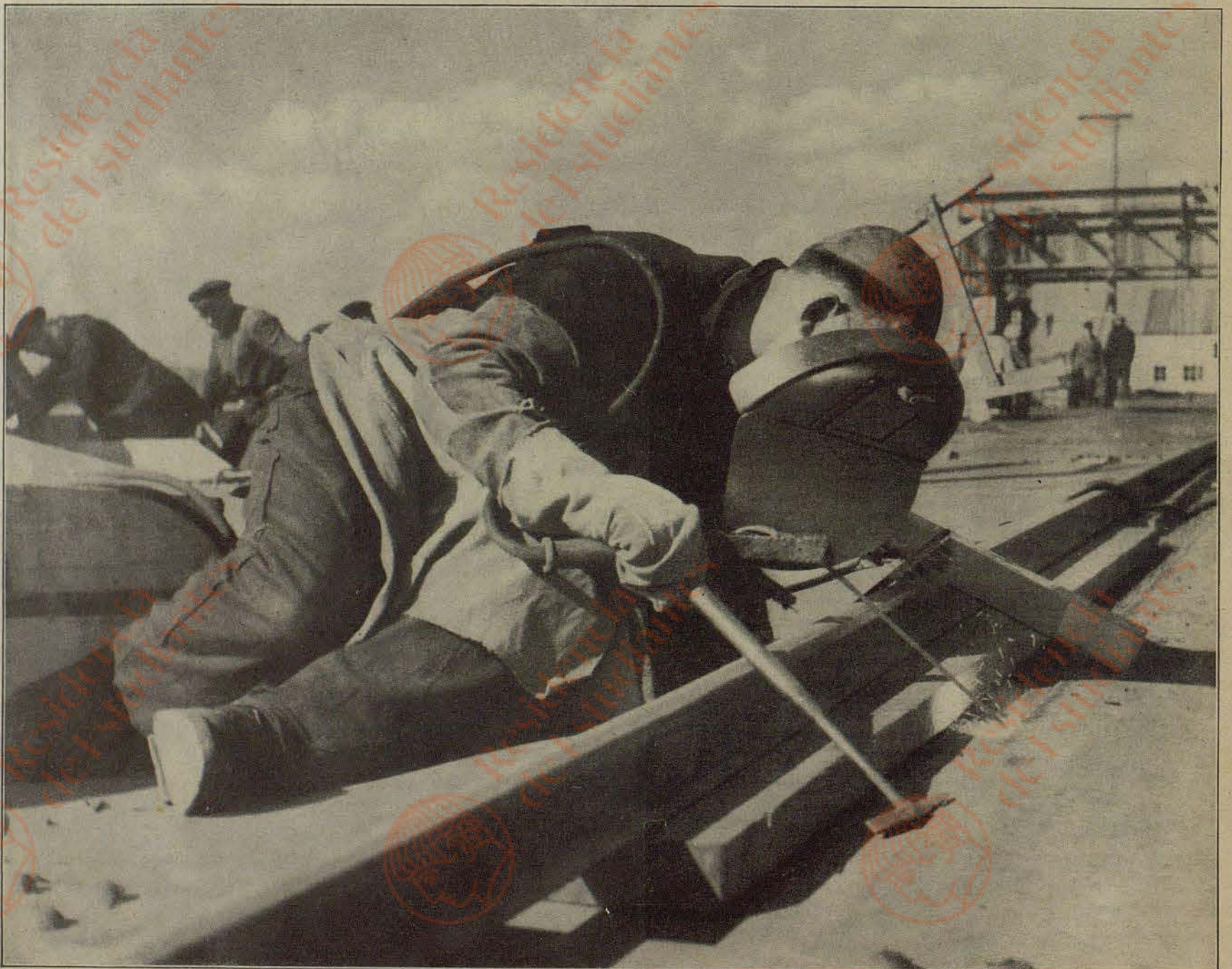
Sorgfältige Arbeit: Ein Schweißer an einer Kreuzung der Reichsautobahn Berlin—Stettin.
