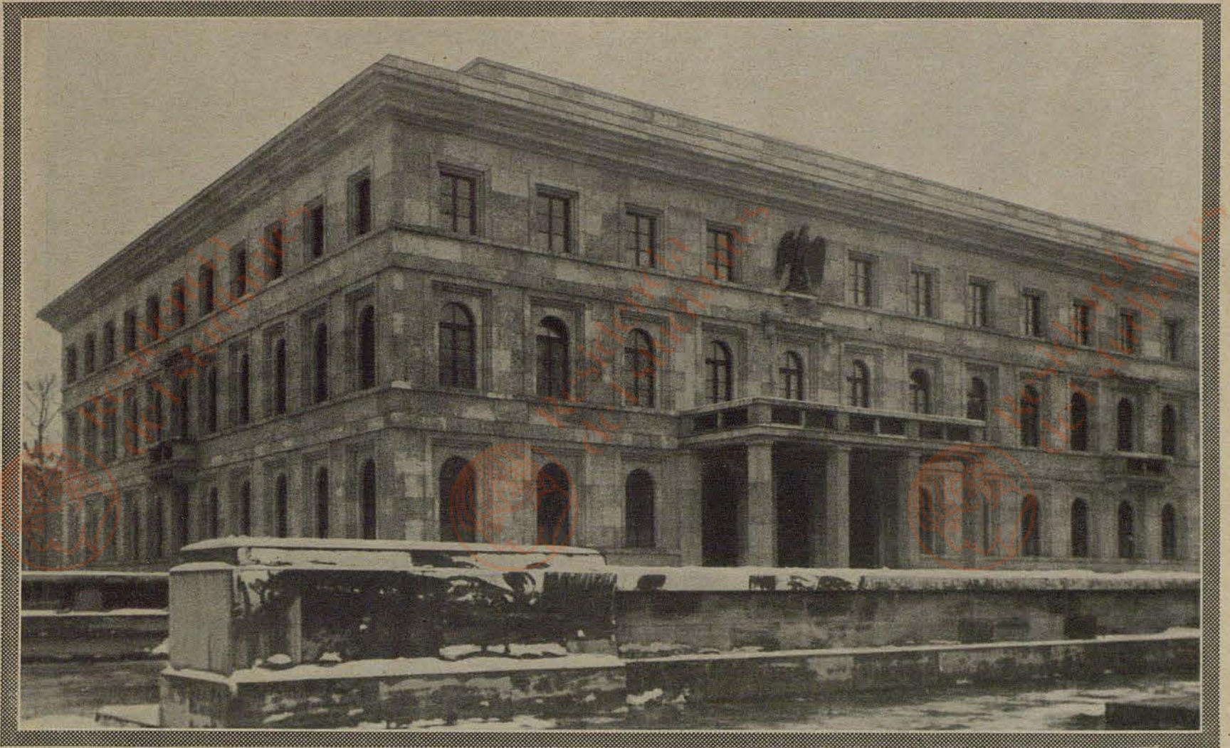
Die Bauten des Dritten Reiches.
