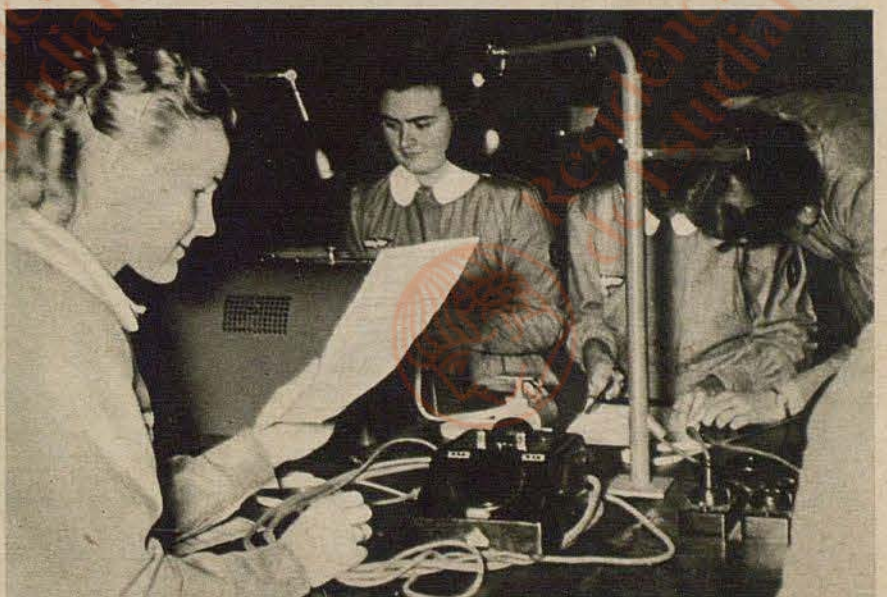
Am Fernschreiber. Eines der kompliziertesten, aber auch wichtigsten Nachrichtenmittel ist der Fernschreiber. Eine gründliche, rein theoretische Vorausbildung macht die Nachrichtenhelferinnen mit der Arbeitsweise dieses Nachrichtengeräts vertraut und befähigt sie, in verhältnismäßig kurzer Zeit auch lange Berichte schnell durchzugeben
